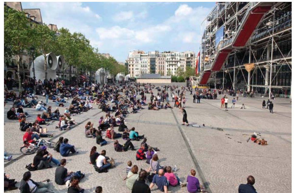
Plassen foran Centre Pompidou i Paris. Et ikonisk kulturbygg som inviterer offentligheten til opphold og tilbyr fleksible rom for kultur og kunst midt i byen. Arkitekt: Renzo Piano & Richard Rogers.
