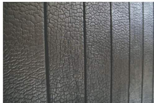
Ferdig overflate - eksteriør
