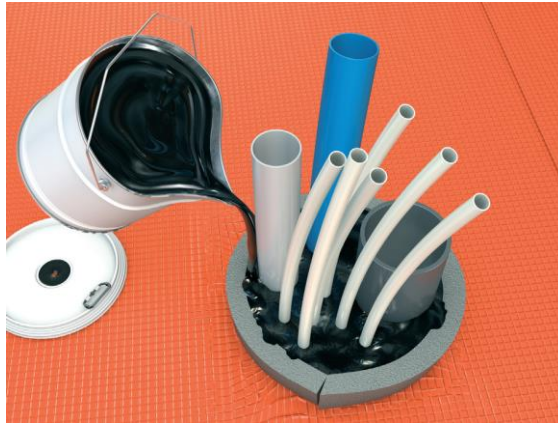
Figur 4 Samling av rør med bruk av flytende tettemasse
