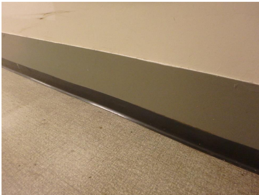
Figur 3: Svart gummilist som inneholder ftalater.
