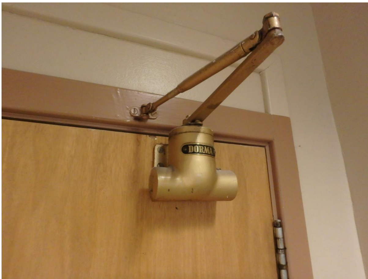
Figur 4: Disse dørpumpene inneholder små mengder olje.
