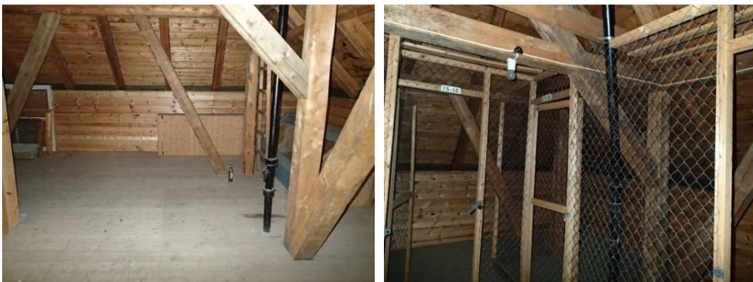
Figur 13. Foto viser typiske konstruksjoner på loft
