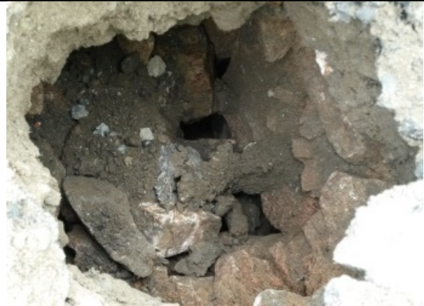
Foto 2. Det var ikke mulig å komme ned gjennom topplaget i punkt S1 da massene bestod av pukke og stein.
