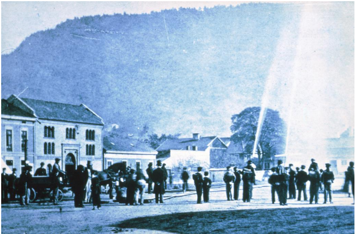
Bildet viser testing av Drammens nye vannverk, som ble bygget ut som følge av bybrannen i 1866
