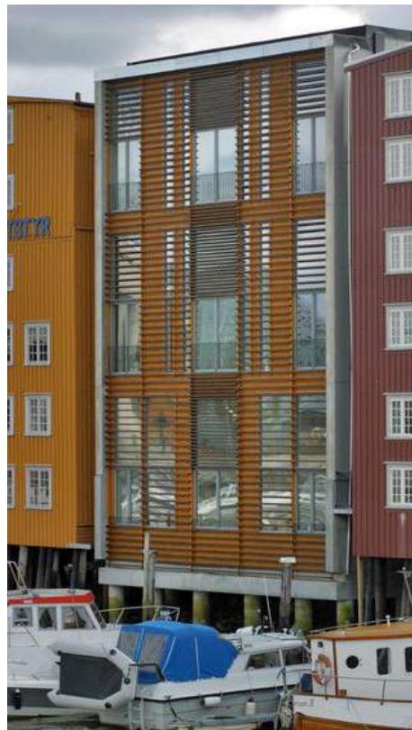
Fjordgata 26 28. Bergersen Arkitekter. Foto viser prinsipper for utforming av bygg i maritime omgivelser.
