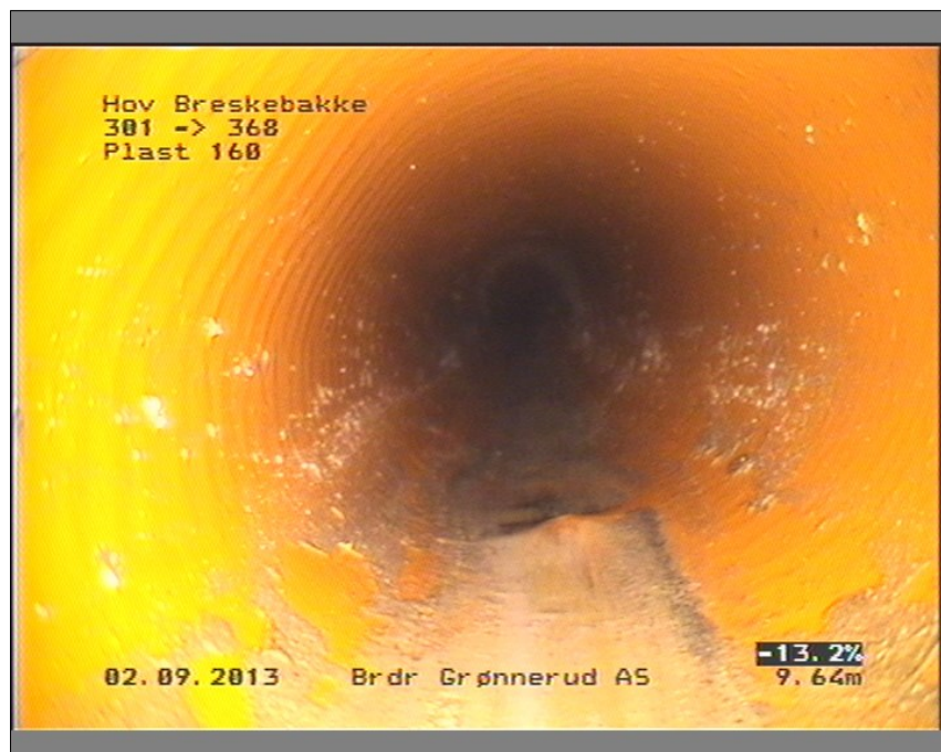
Foto: 2_2_15_B.JPG 3,57m, Deformasjonen er 5 % eller mindre av rørdimensjonen, fra 03 til 09 Kl., Punkt deformasjon, Start
