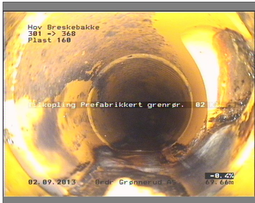
Foto: 2_2_28_A.JPG 69,66m, Tilkopling Prefabrikkert grenrør. 02 Kl.
