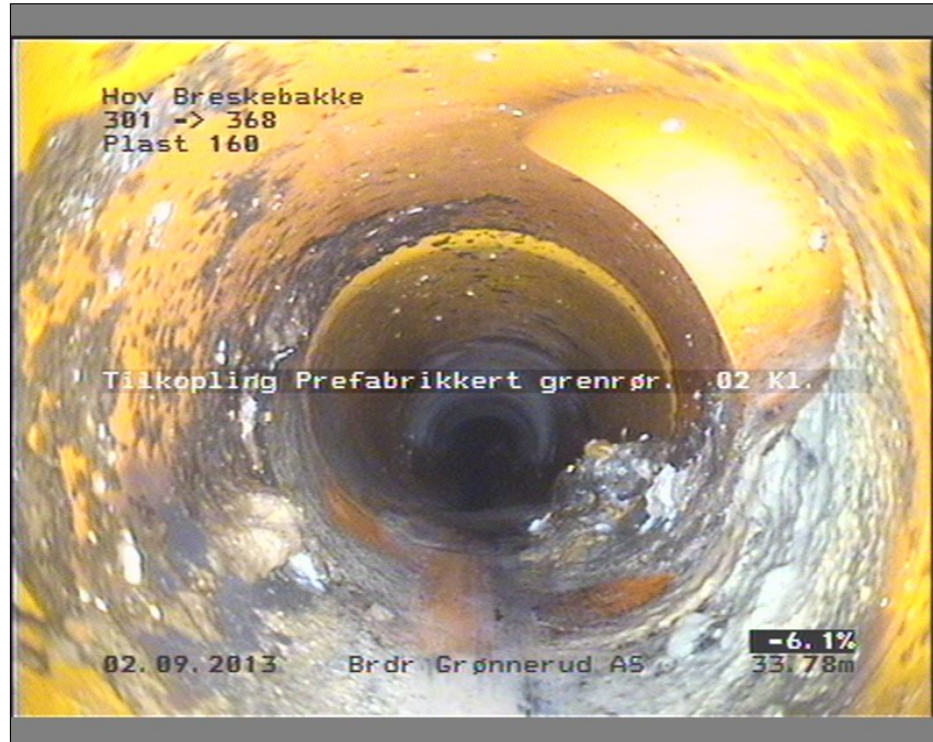
Foto: 2_2_16_A.JPG 33,78m, Tilkopling Prefabrikkert grenrør. 02 Kl.
