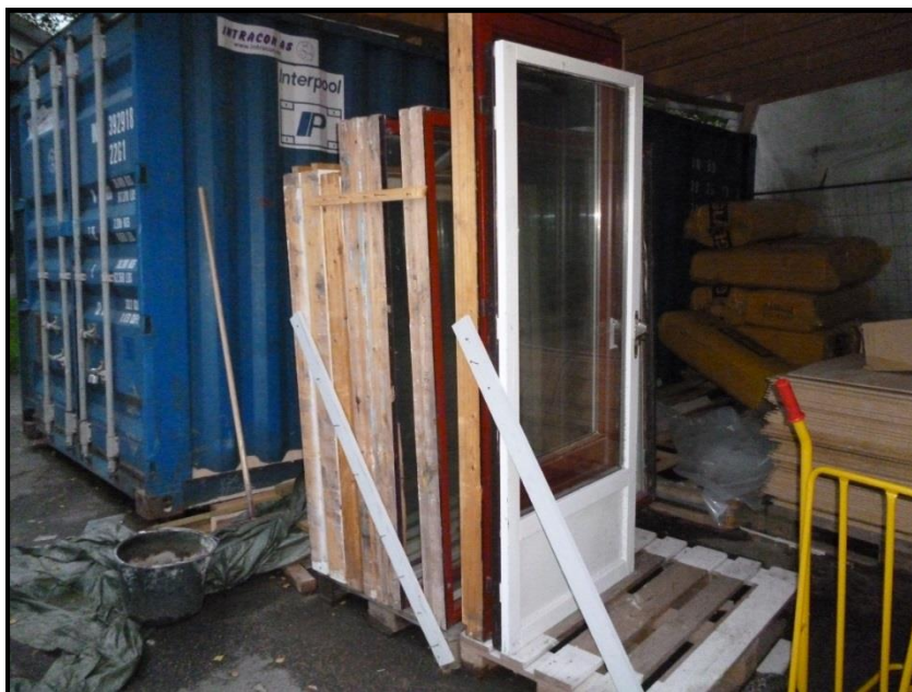
Figur 16: Slik kan vinduer og balkongdører klargjøres for transport.
