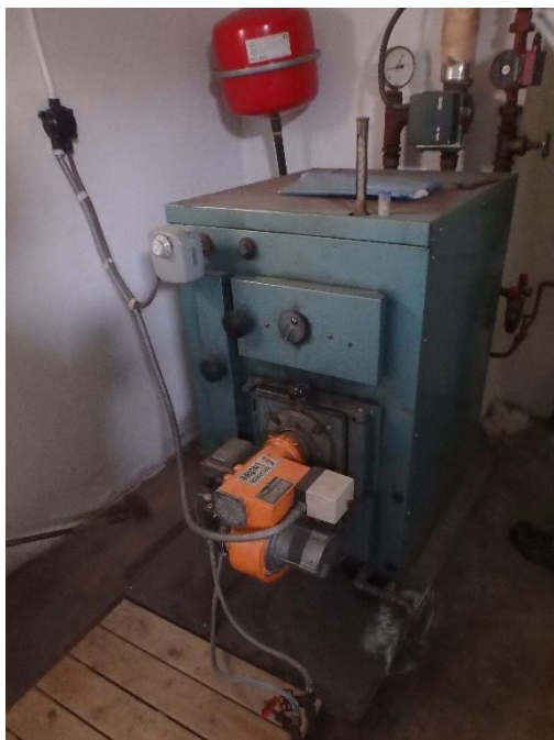
Figur 13: Oljefyr i kjeller.
