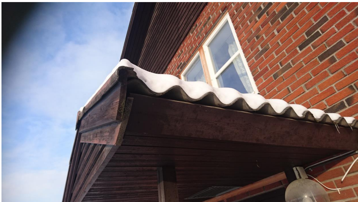
Figur 3: Taket på murbygningen består av eternitt bølgeplater.
