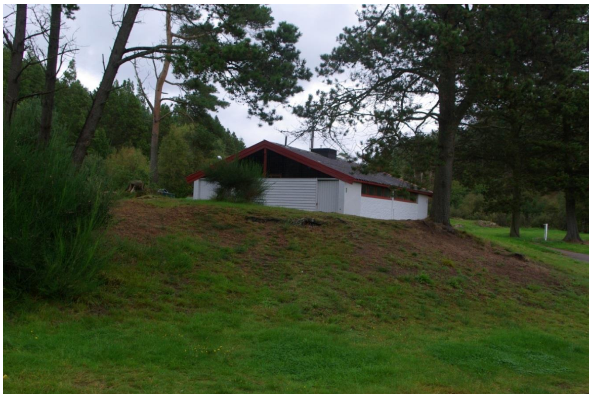
Figur 5. Sanitærbygg er fra 1970-tallet. Foto: Bjørn Vikøyr.
