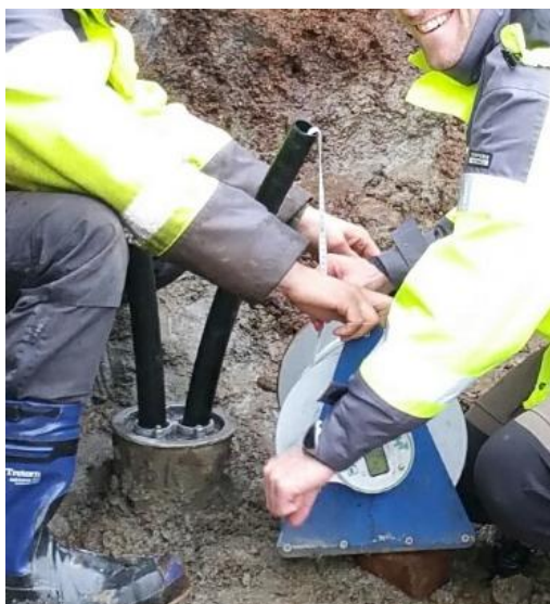
Figur 10. Temperaturprofilmåling der målesonden føres ned i det ene kollektorrøret.
