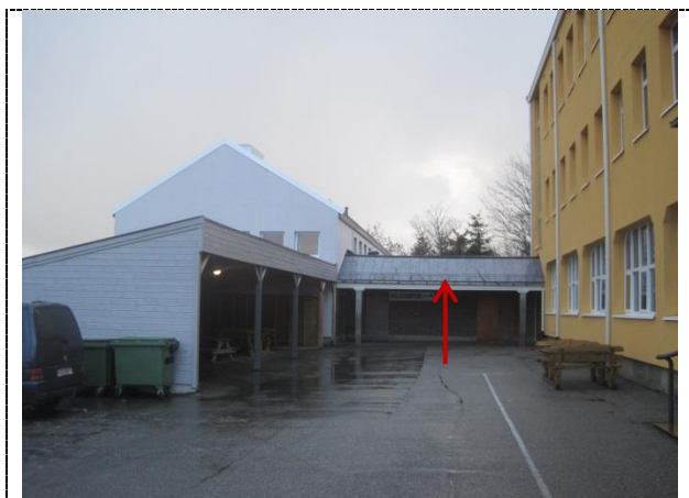
Bilde viser takoverbygg med 8 m utstrekning mellom gymnastikk til venstre og skolebygg 1.
