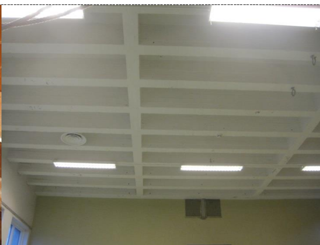
Bilde viser takkonstruksjon i gymsal som er utført i betong.
