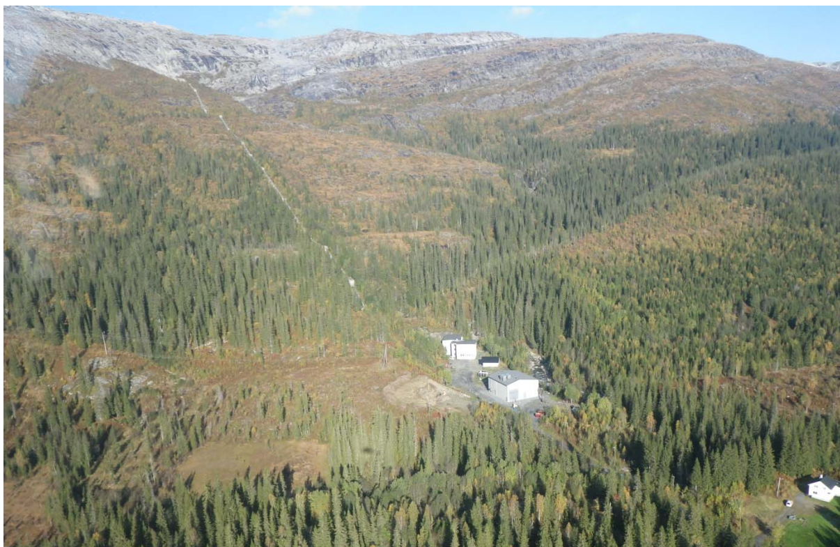
Figur 2 Oversiktsbilde Kaldåga kraftverk
