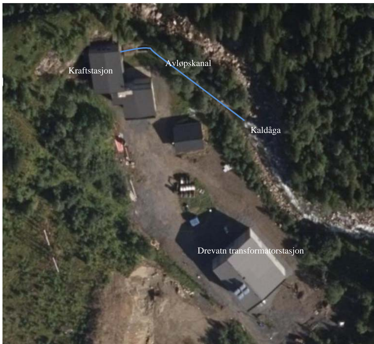
Figur 5 Flyfoto eksisterende anlegg.
