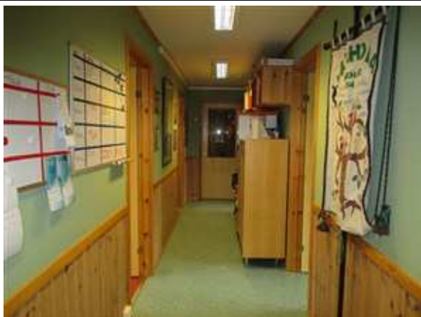
Bilde 3.5 Vinyl gulvbelegg i korridor
