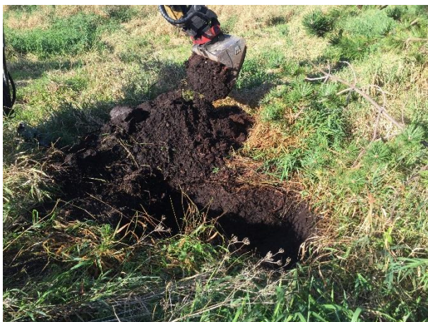
Figur 6. Graving i organiske masser i dalen.
