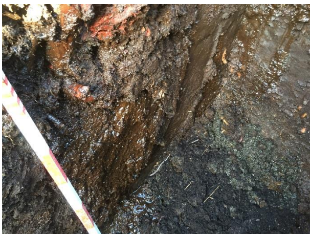
Figur 8. Grunnvann strømmer in i sjaktene i dalen.
