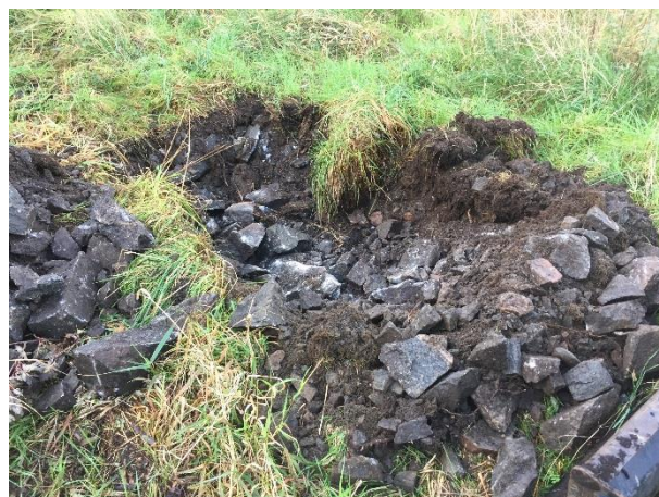
Figur 9. Graving i veien. Mest sprengstein, noe matjord.
