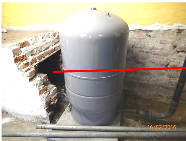
Bilde 37: Det ble registrert en ovn i rom 1AK som ble brukt til fyring før.
