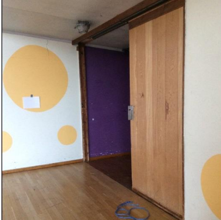
Bilde 30: Isopordør ble registrert i rom 36C.
