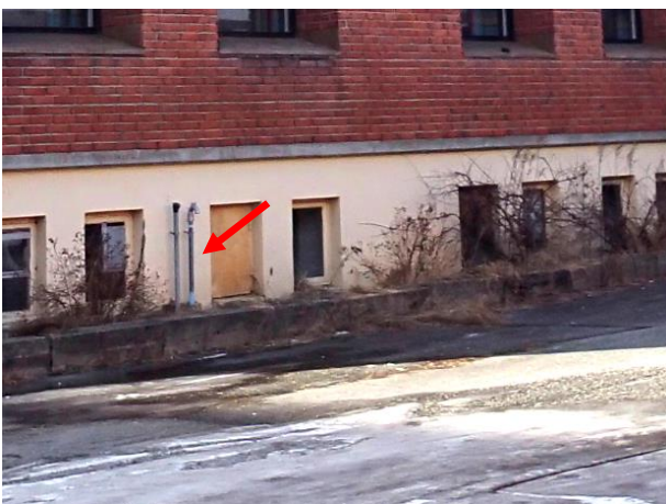
Bilde 34: Det ble registrert to påfyllingsrør i øst fasaden til bygg A.
