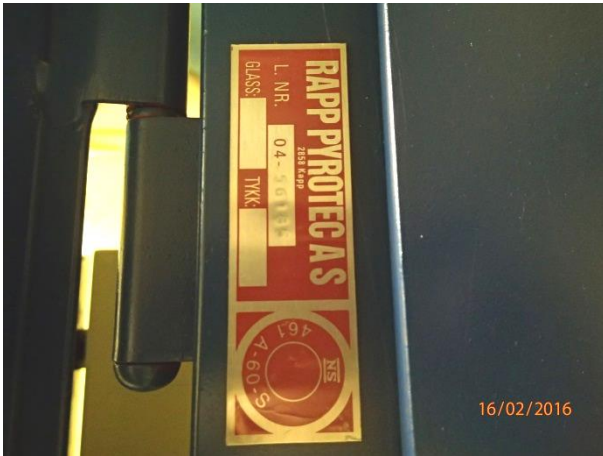
Bilde 9: Eksempel på brannør i kjeller av A-fløy.
