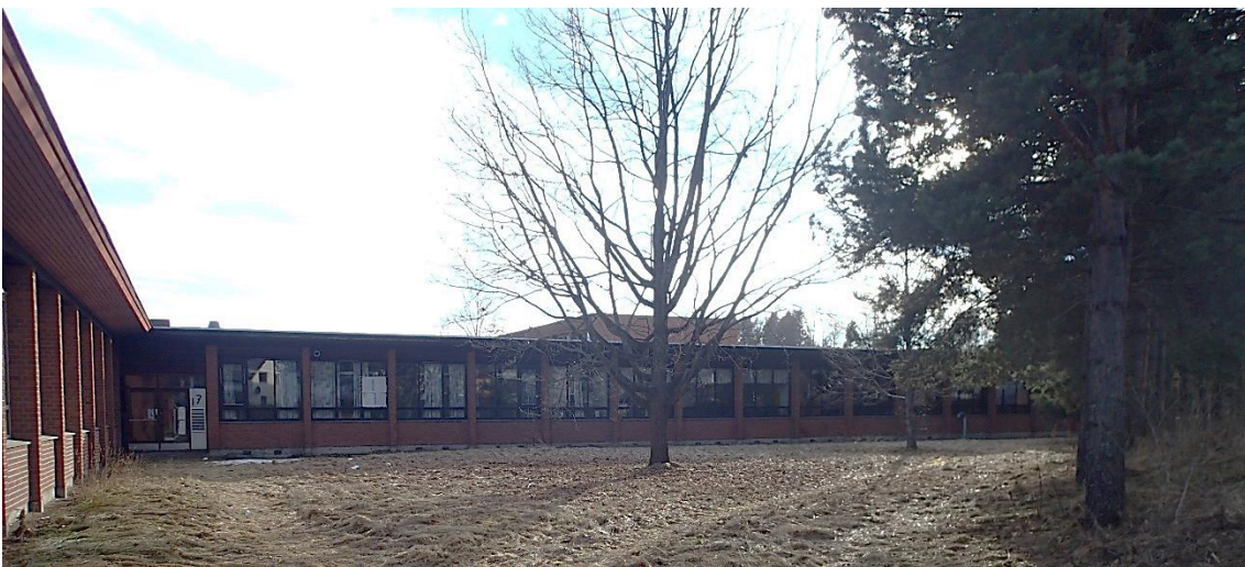
Bilde 6: Fasade mot nordvest, D- og B-fløy
