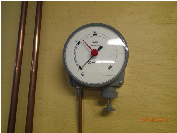
Bilde 13: Trykkmåleren kan inneholde kvikksølv i seg. Registrert i rom 1AK.
