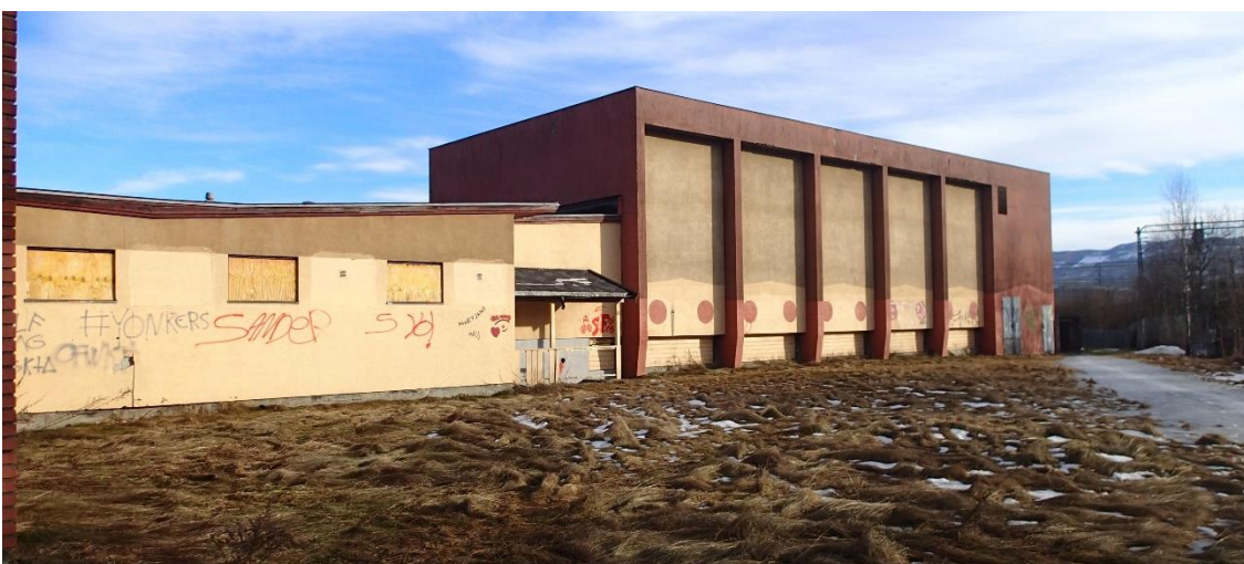
Bilde 3: Fasade mot vest, C-fløy, gymnastikk bygg
