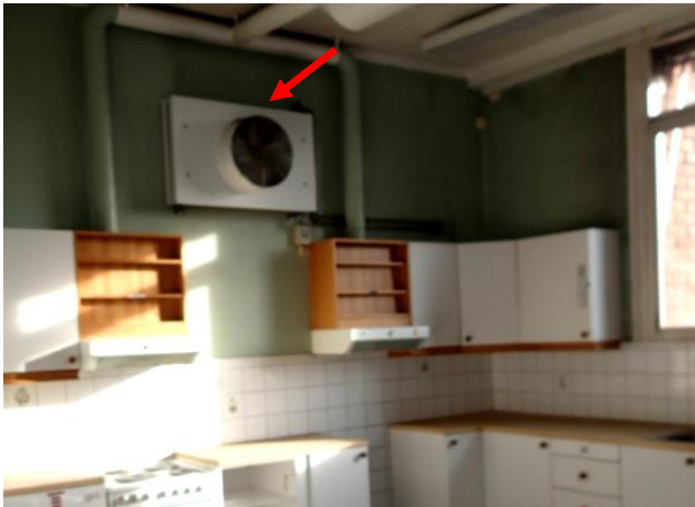
Bilde 32: Eksempel på kjølemaskin.
