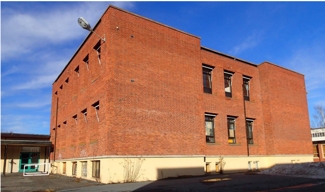
Bilde 2: Fasade mot sør, A-fløy
