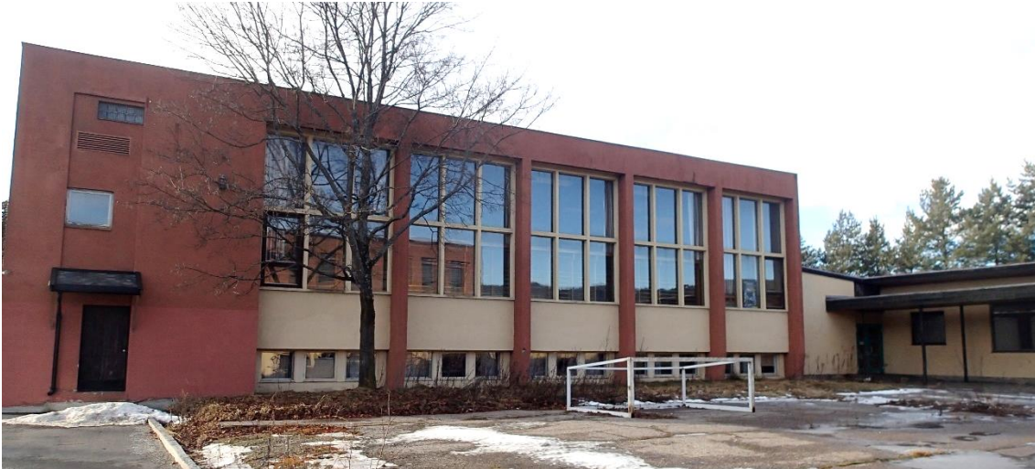
Bilde 4: Fasade mot øst, C-fløy, gymnastikk bygg
