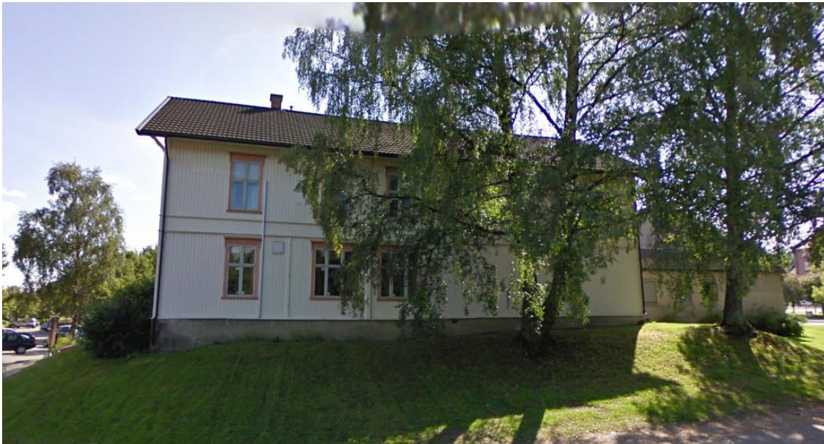
Bilde 1: Fasade mot nord (bilde hentet fra www.google.no/maps )
