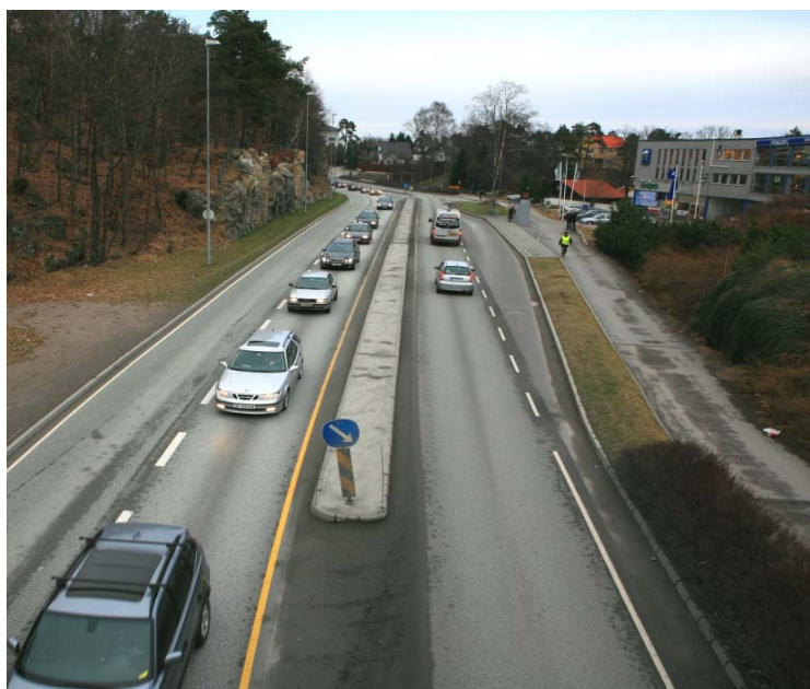
Ettermiddagsrushet ved Blørstad i Vågsbygd
