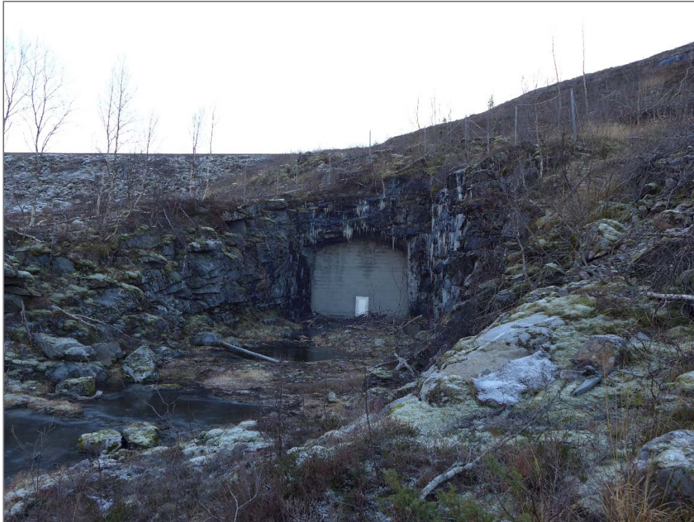
Bilde 15 Utløp østre omløpstunnel. Denne er gjenstøpt. Subhorisontal lagdeling er veldig tydelig.
