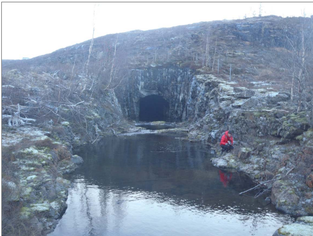
Bilde 16 Utløp vestre omløpstunnel.
