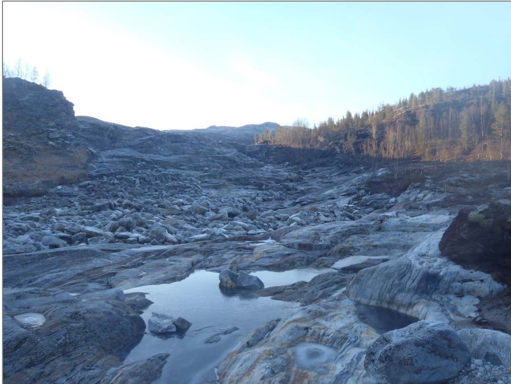
Bilde 13 Fra elveleiet opp mot avsats til platå ved overløp. Bildet er tatt motstrøms, mot sør.
