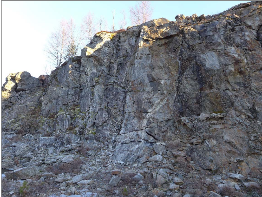
Bilde 9 Nedstrøms ende av skjæring ved overløp. Granittisk gneis med bånd/slirer av glimmergneis. Det er observert avløste steiner/blokker i skjæringen. Skjæringen er inntil ca. 10 m høy. Bildet er tatt mot ØNØ.
