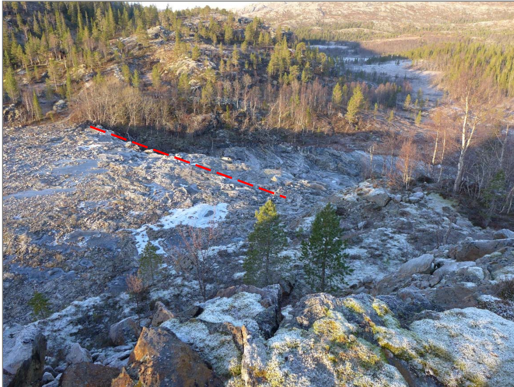
Bilde 11 Platå nedenfor overløpsterskel til venstre, avsats i terrenget (stiplet) ned til elveløpet videre nedstrøms. Bildet er tatt mot NV.
