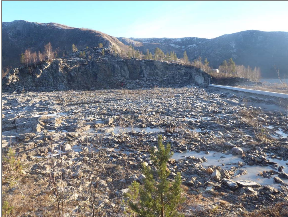
Bilde 7 Overløpsterskel til høyre i bildet. På platået nedstrøms terskelen ligger mindre blokker spredt utover. Steinuttak til eksisterende dam ble gjort her. Bildet er tatt mot øst.
