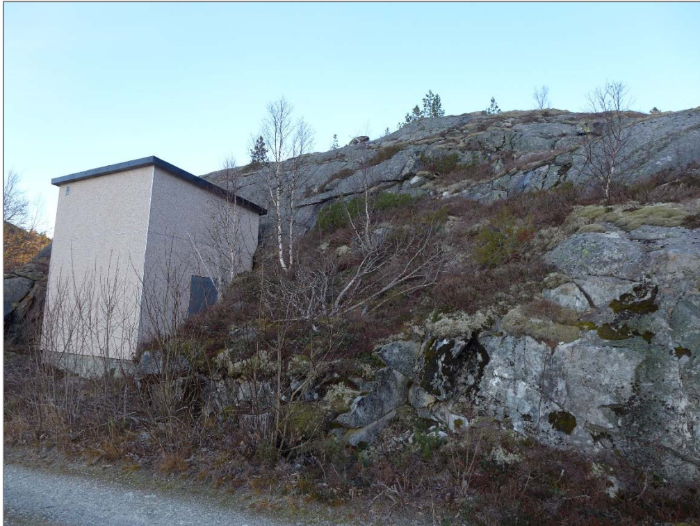
Bilde 3 Lukehus til vestre omløpstunnel. Bergmassen fremstår som kompetent og lite oppsprukket. Granitt/granodioritt.
