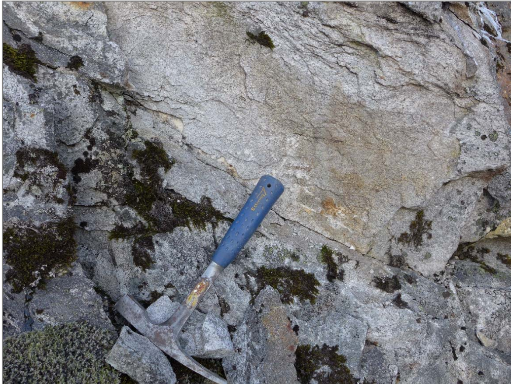
Bilde 5 Granitt i skjæring ved høyre side av overløpsterskel (sett medstrøms).
