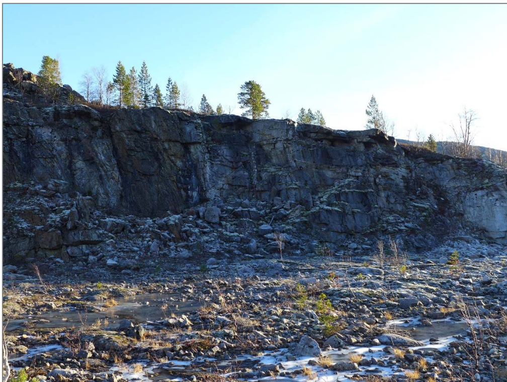
Bilde 10 Oppstrøms ende av skjæring ved overløp. Granittisk gneis med bånd/slirer av glimmergneis. Bergmassen er oppsprukket etter 3 hovedsprekkesett, hvorav to steile og ett subhorisontalt. Bildet er tatt mot øst.
