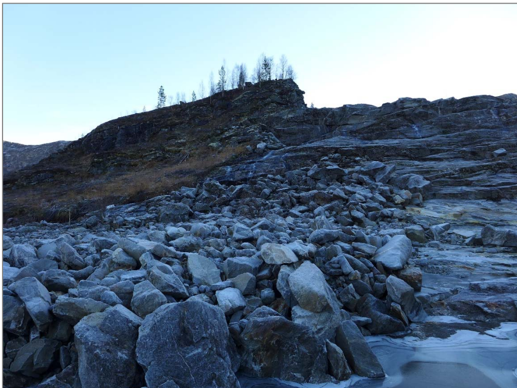
Bilde 14 Fra elveleiet opp mot avsats til platå ved overløp. Det ligger en del blokker i elveleiet, flere i størrelsesorden 0,5-1,0 m 3 . Noe av massene antas å ligge igjen fra anleggstiden.
