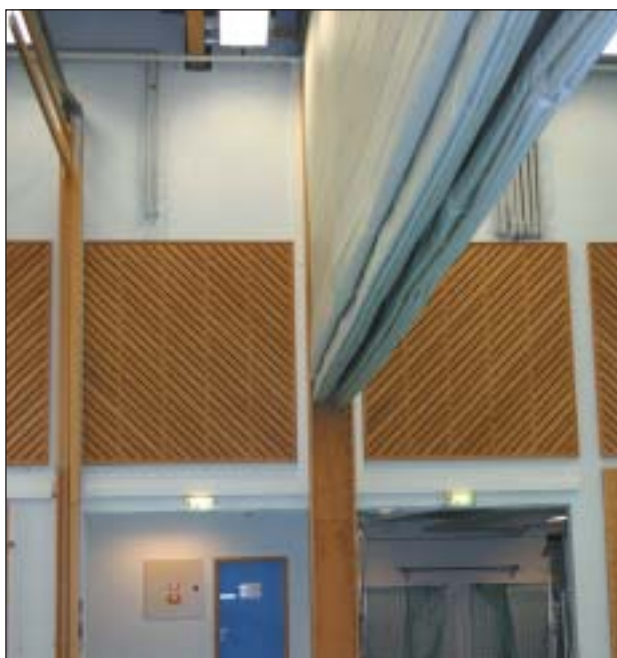
Bilde: Dobbel skillevegg, som gir effektiv lydisolasjon. Merk slissen for enden..
