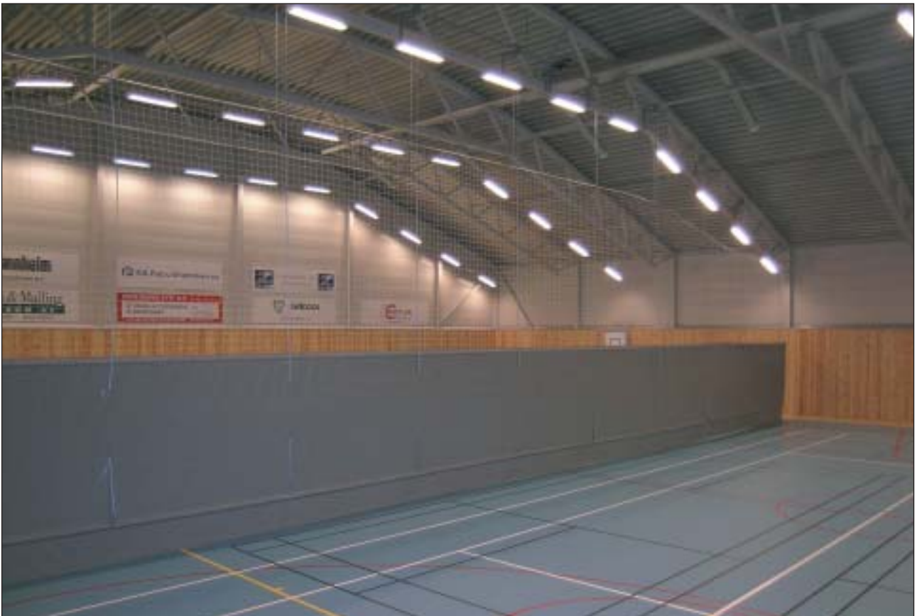
Bilde: Mange aktiviteter inngår i en moderne flerbrukshall, her fra nye „Bygdøhus“.
