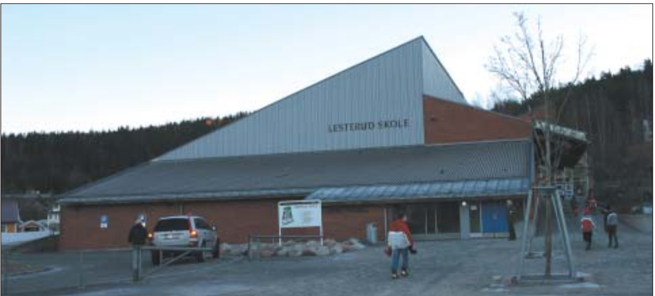
Bilde: Eksempel på en flerbrukshall med mål og hallfunksjoner tilpasset nærmiljøets behov (Lesterud skole i Bærum).
