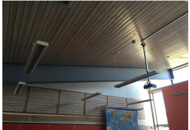
Eksist. skråtak med nedhengt belysning
