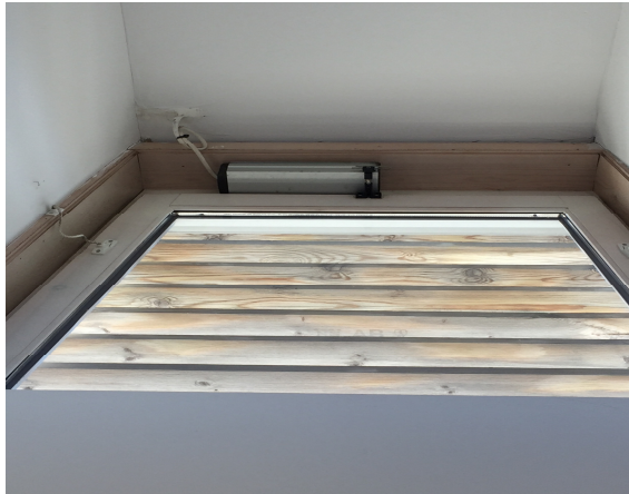
Eksist. ventilasjonshatt med styring
