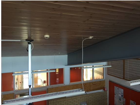
Eksist. skråtak med nedhengt belysning
