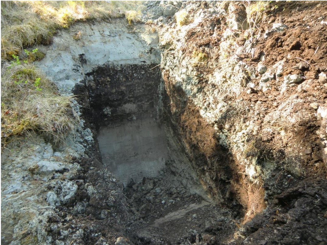
Figur 2: Sjaktgrop 1. Oppfylt silt over torv, overgang til silt igjen ved ca 1,5 m.
