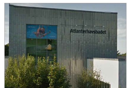
DAGENS FASADE MOT SØR (RHEINZINK® RZ-SINK)
