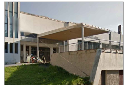
DAGENS HOVEDFASADE MOT NORD
