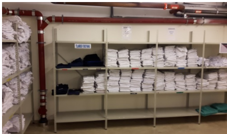
Figur 2 spillvannsrør skal heves over ny dør
