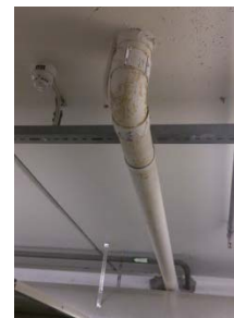
Figur 3 Overvanns rør i tak
