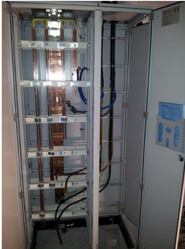
Figur 7: Eksempel på tilkobling av tilførselskabler til strømskinner
