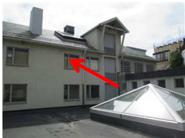
Bilde 3.12 Vinduer inn mot tak. Vinduene består av enkle glass.
