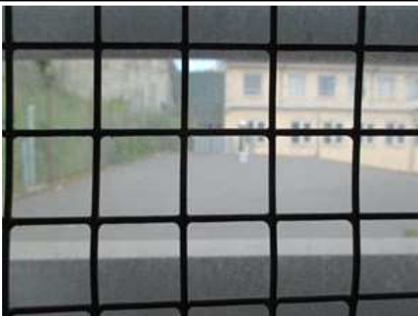
Bilde 3.6 Vindu som kan inneholde bly.
