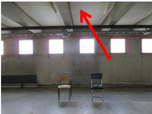
Bilde 3.7 Isoporplater i himling
