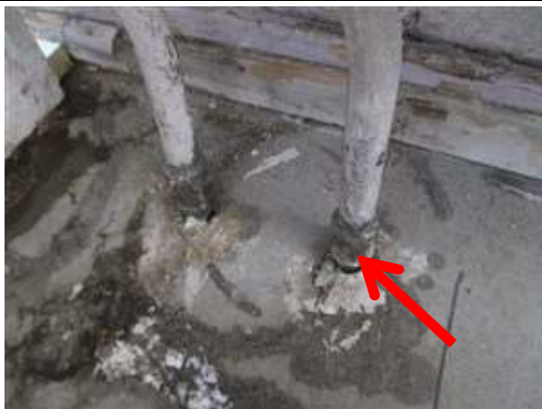
Bilde 3.1 Pakninger i gjennomføringer ifm. sentralvarmeanlegg
