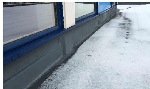
Foto 9 – Mot yttervegg / Vindusbånd
