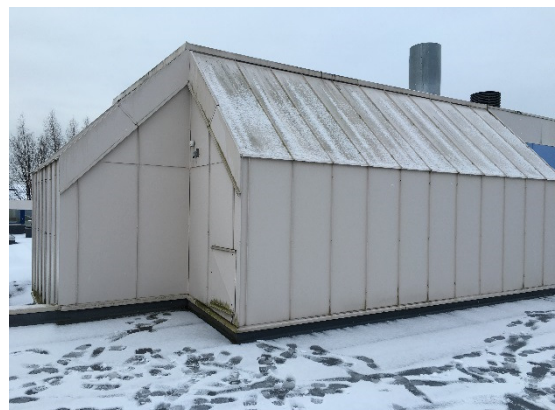
Foto 11 – Ventilasjonshus, Skive/båndtekkning
