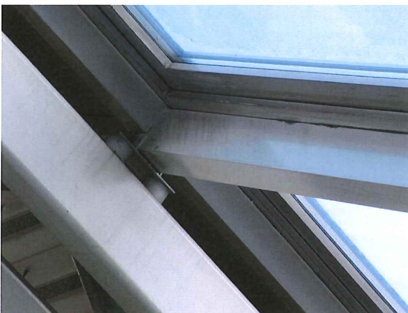
Fig 6 Innvendig toppdetalj og øvre hjørne lufteluke.
