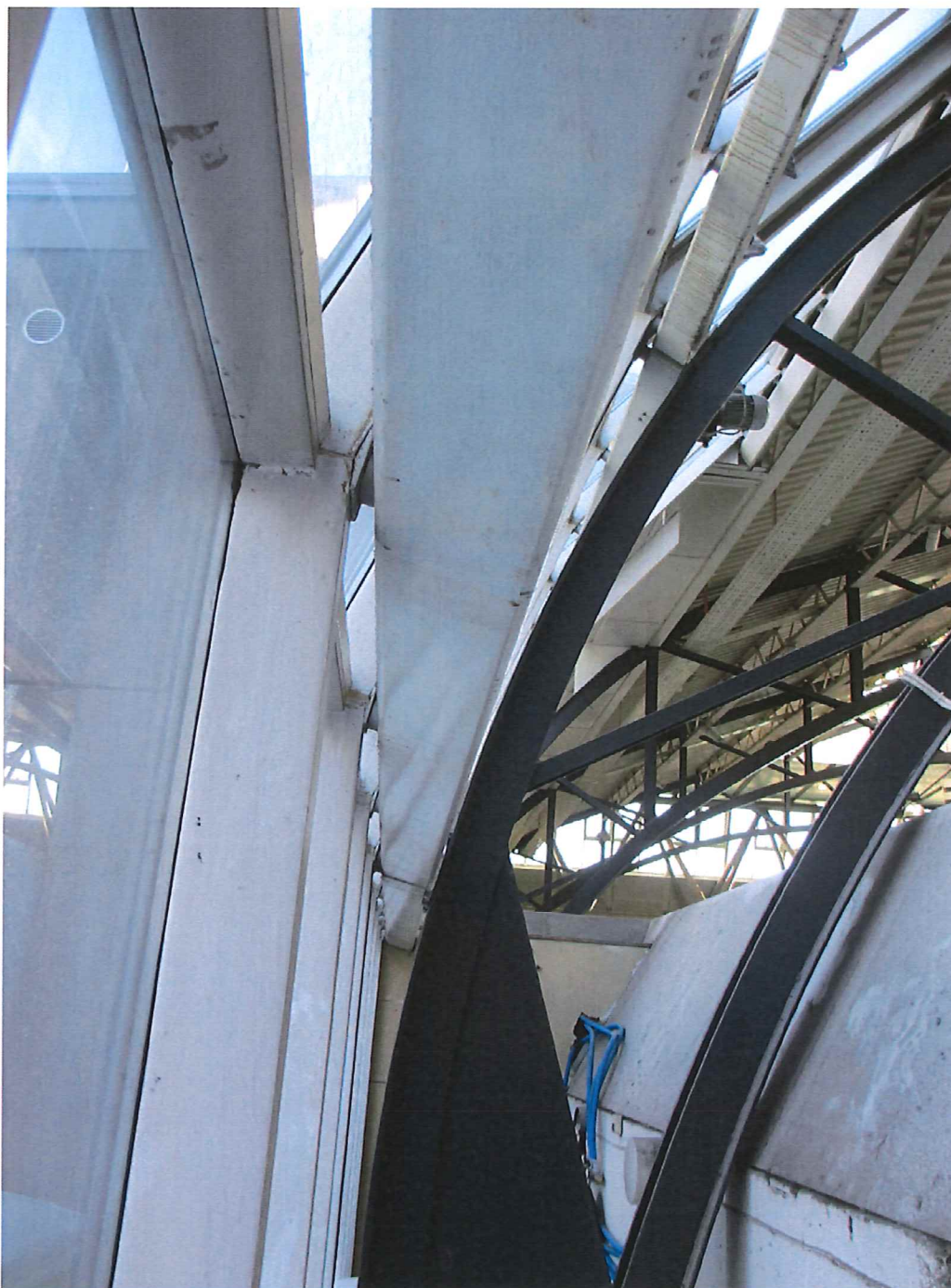
Fig 4 innvendig side, vinkelendring og innvendig horisontalt stål.
