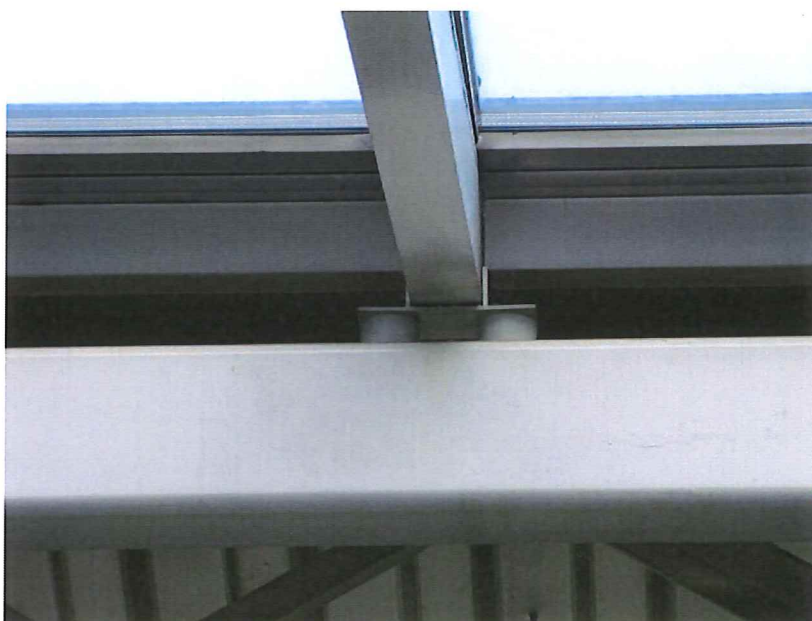
Fig 5 Innvendig innfesting toppdetalj
