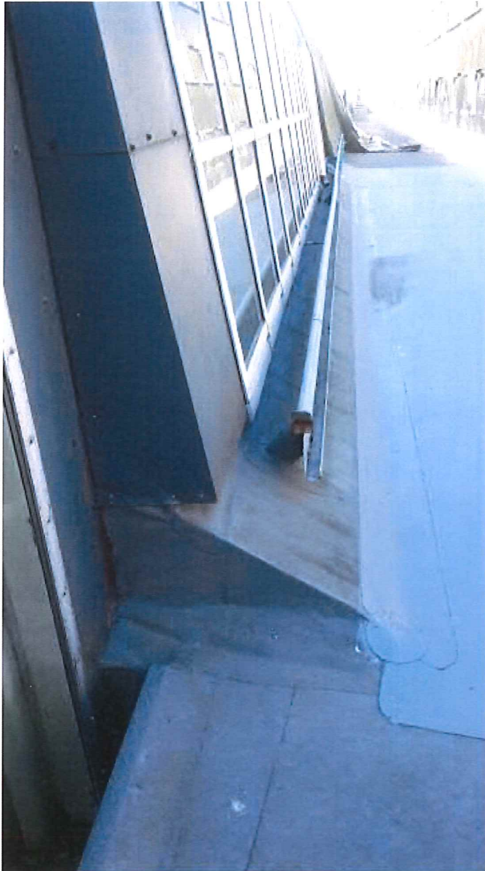
Fig 4. Resten av glasstakskonstruksjon del to. Denne er lik glasstaket mot sør, men har overgang til flatt tak i to forskjellige høydenivåer. Foto: Rambøll.
