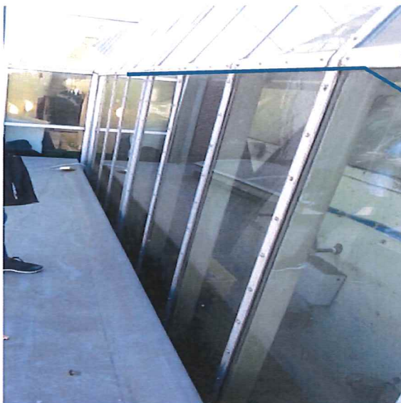
Fig 11 Illustrasjon av "Knekk" i det innvendige hjørnet. Foto Rambøll.
