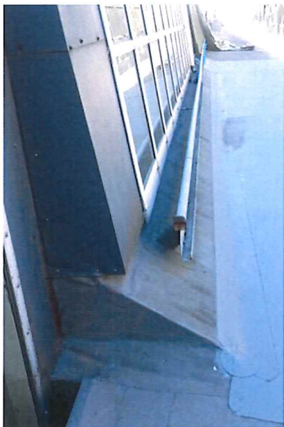
Figur 25: Foto av overgang lett-tak og opprinnelig glasshall (Rambøll)
