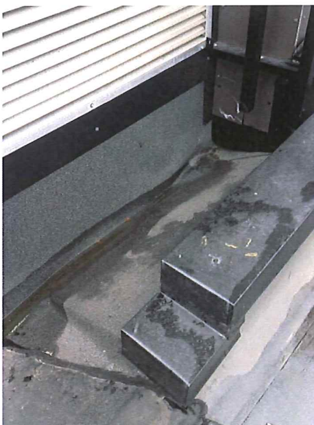
Figur 21 a og b: Foto av nedsenk ved ventilasjonskasse (Rambøll)
