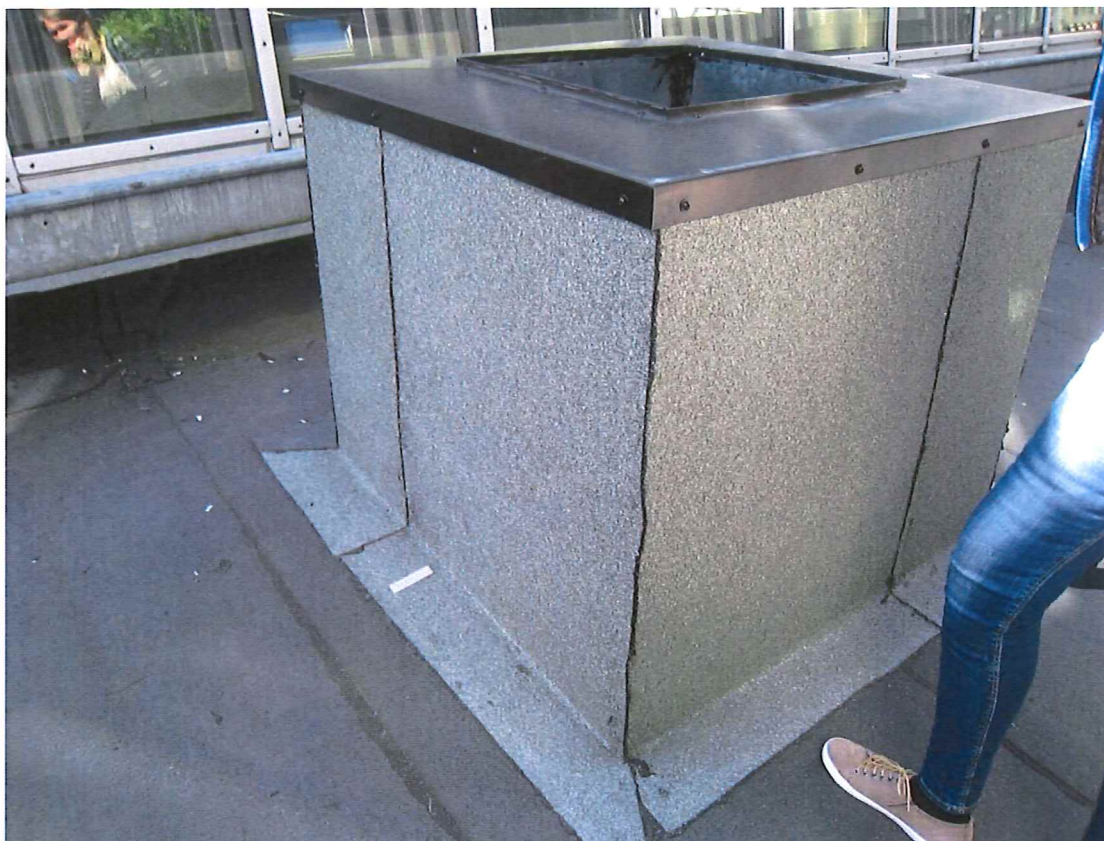
Figur 31: Foto av tekket ventilasjonskasse (Rambøll)
