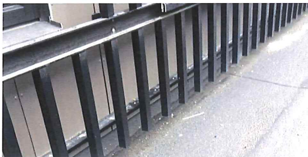
Figur 11: Foto av oppkant tekking i overgangen tak/yttervegg i nord
