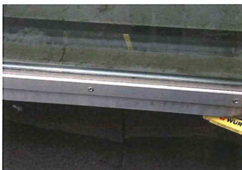
Figur 23: Foto av overgang flatt tak/opprinnelig glasshall på tak nord
