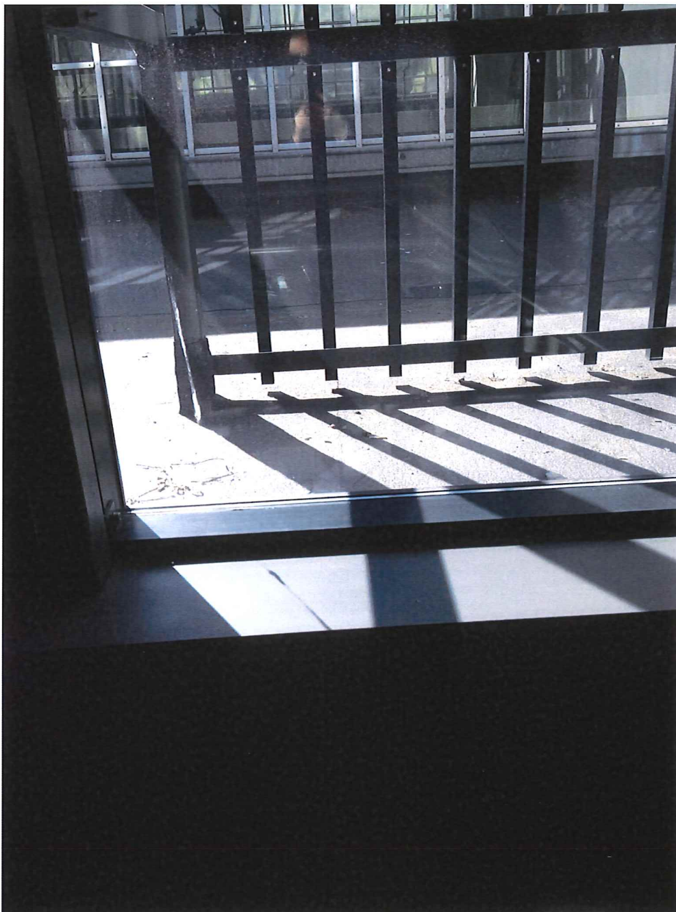
Figur 33: Foto av søylerekke foran «inngangsparti» sett innenifra (Rambøll)
