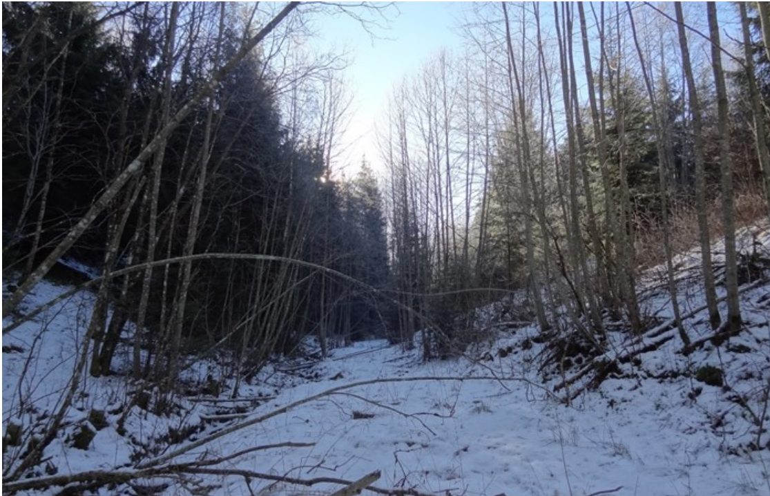
Figur 6: Nedre del av ravine som går nord-sør i sonen. Det er litt erosjon i bekken. Mulig tilgang i ravinen. Det ligger spillvannsledning under anleggsveien.
