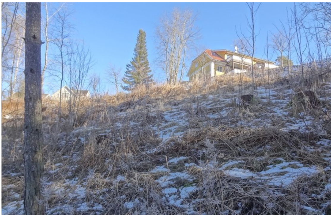
Figur 13: Skråningen der skredet skjedde i 2013. Skråningen er avgravd, trær er felt og skråningen er delvis sikret.
