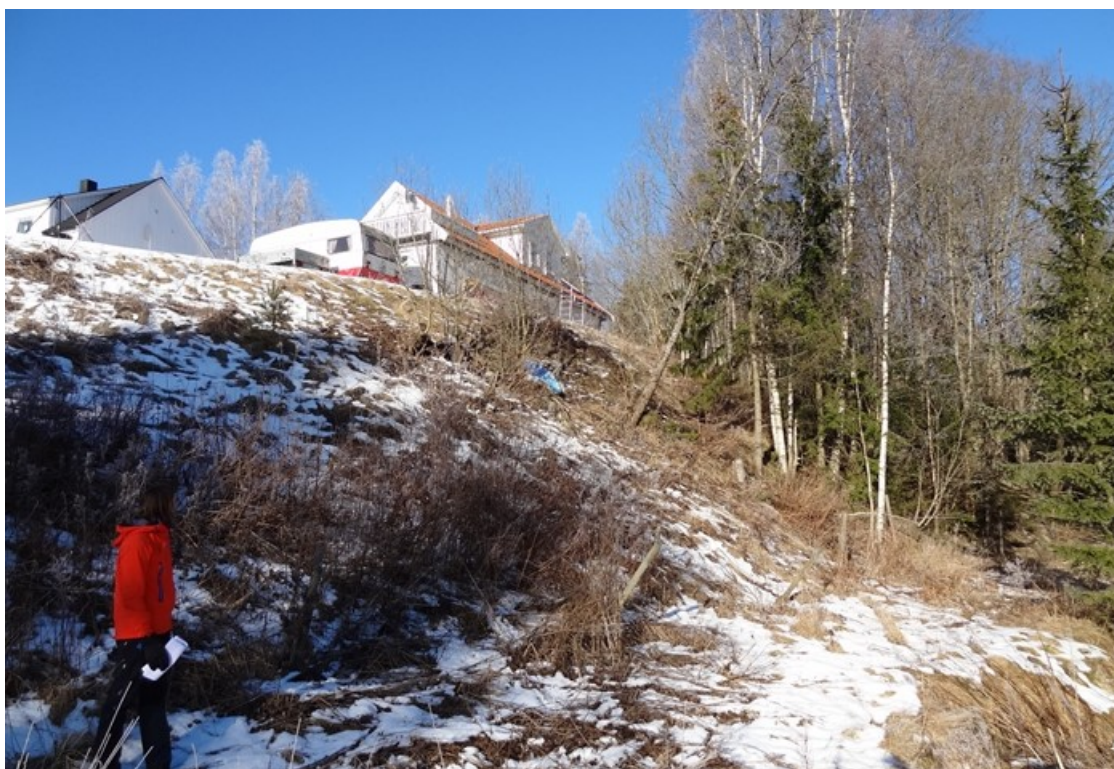
Figur 8: Mye utfylte masser på sidene av platået ved Skriken. Stedvis er helningen brattere enn 1:2.
