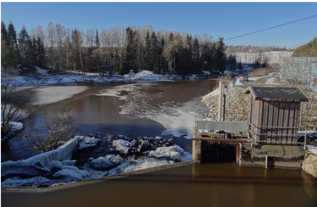
Figur 10: Foss der Svaleveien går over Rakkestadelva. Det er sikret langs deler av strekningen langs sonen.
