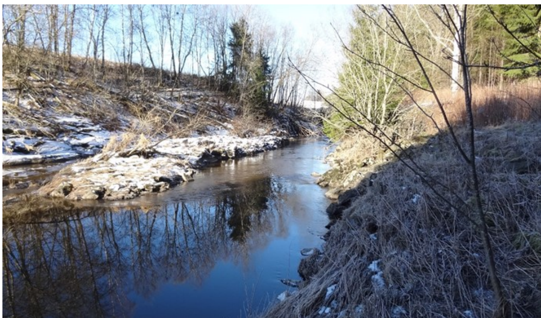
Figur 14: Fjellterskel i Rakkestadelva. Skråningen er delvis sikret langs Rakkestadelva.
