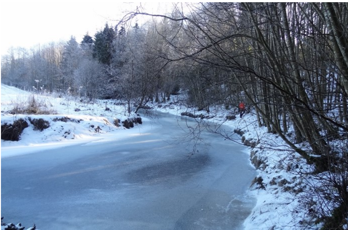
Figur 5: Lite/noe erosjon langs yttersving av Dørja. Vanskelig tilkomst til skråningsfot. Sett motstrøms.
