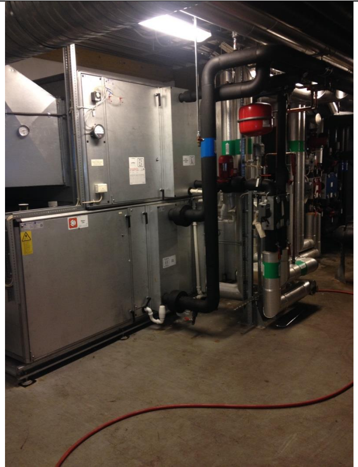
Bilde 2. Eksisterende vent.agg. som skal utskiftes
