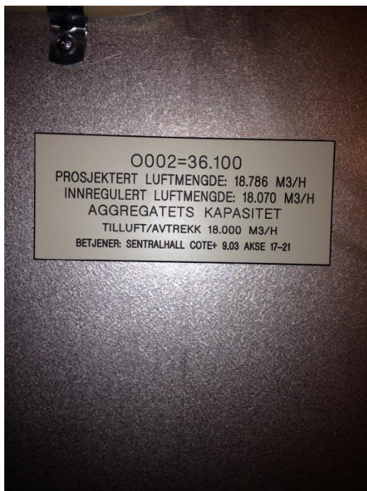
Bilde 1. Eksisterende vent.agg. som skal utskiftes
