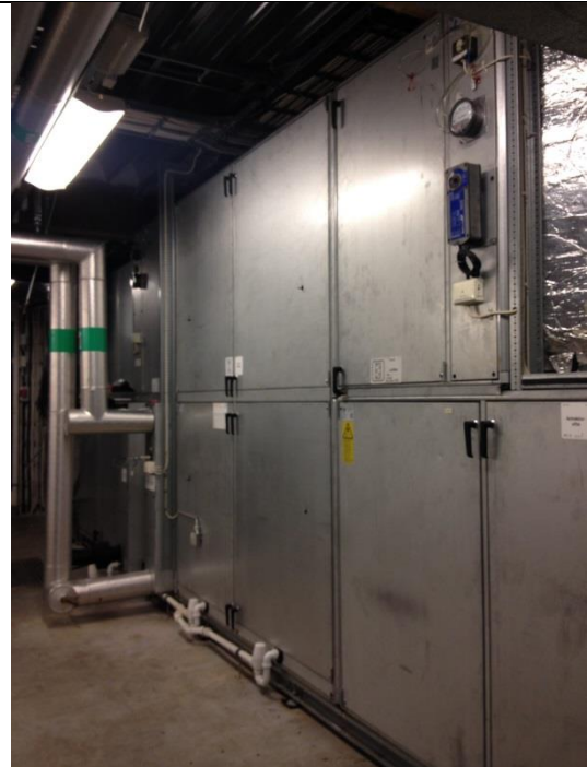
Bilde 2. Eksisterende vent.agg. som skal utskiftes
