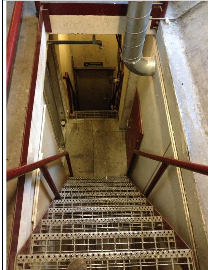
Tilgang til teknisk rom
