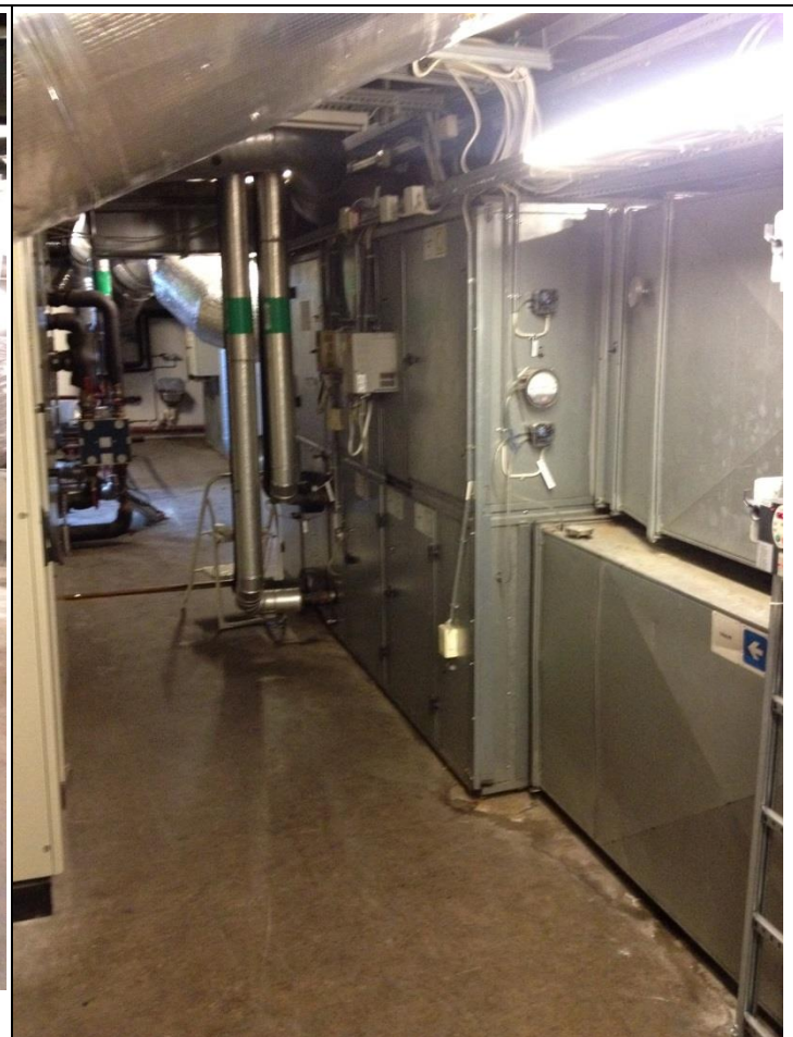
Bilde 2. Eksisterende vent.agg. som skal utskiftes
