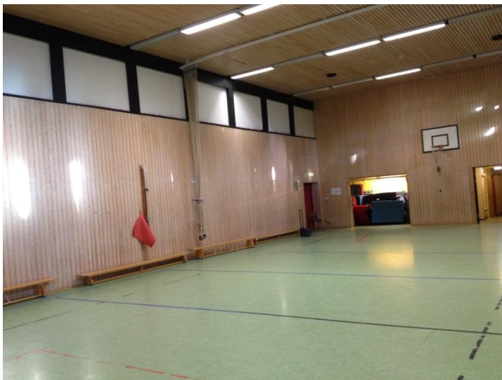
Figur 10 Det er klorparafiner i det grønne gulvbelegget i gymsalen
