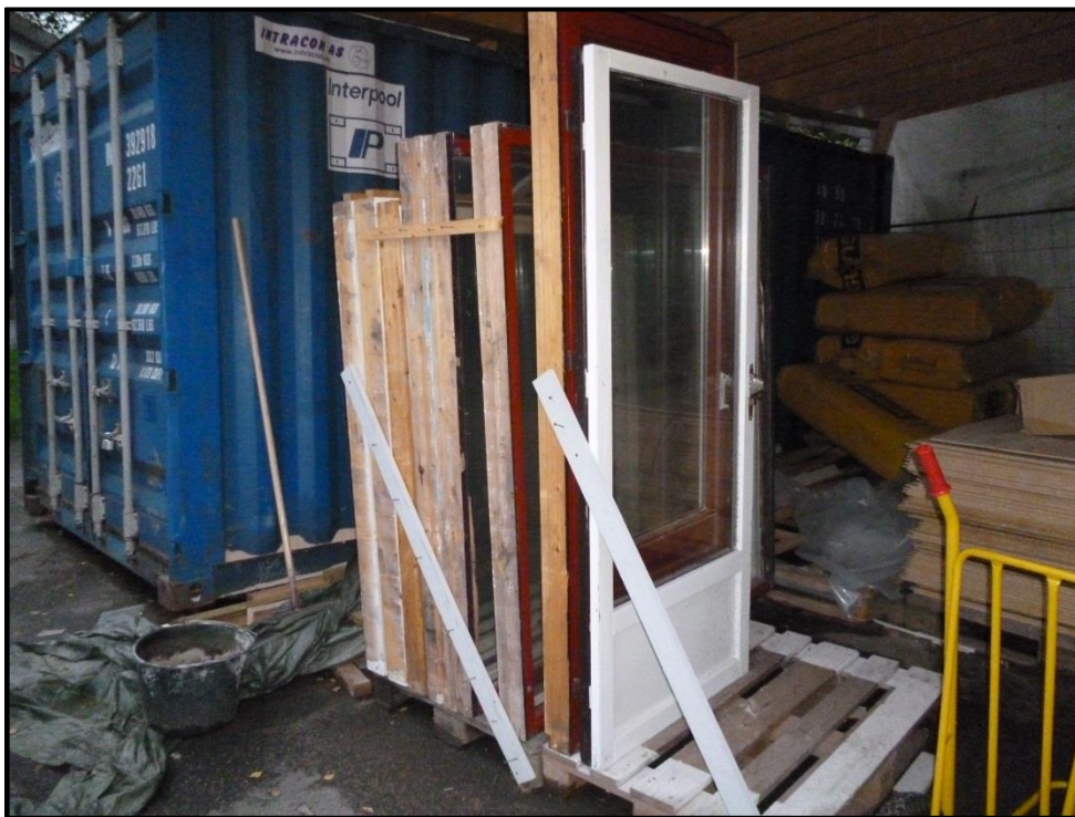
Figur 14 Slik kan vinduer og balkongdører klargjøres for transport.
