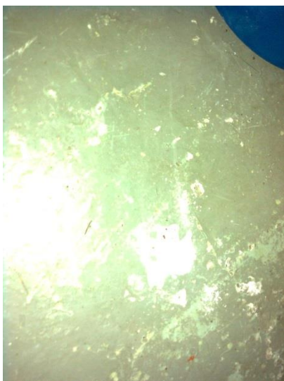
Figur 4 Grå gulvmaling i berederrom inneholder mye bly.
