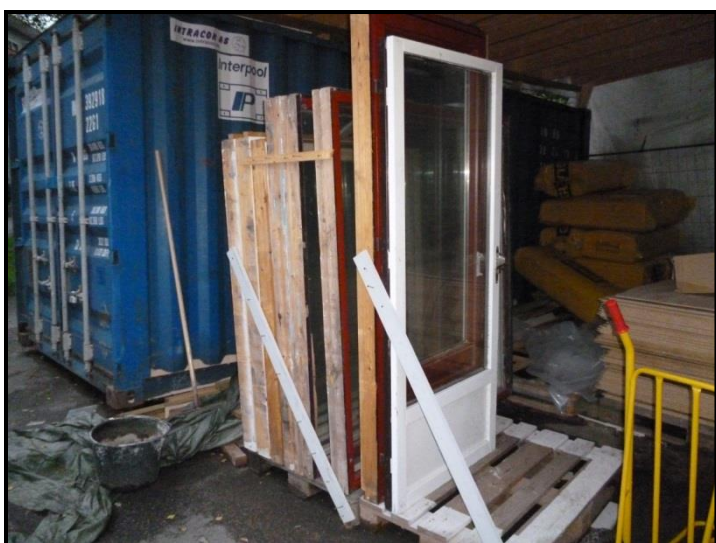
Figur 5 Slik kan vinduer og balkongdører klargjøres for transport.
