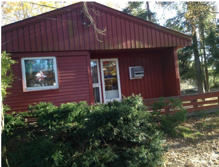
Figur 4 Utvendig trekledning er CCA-impregnert. Terrassen er bygd av CCA-impregnert treverk.
