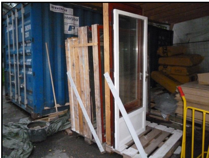
Figur 8 Slik kan vinduer og balkongdører klargjøres for transport.
