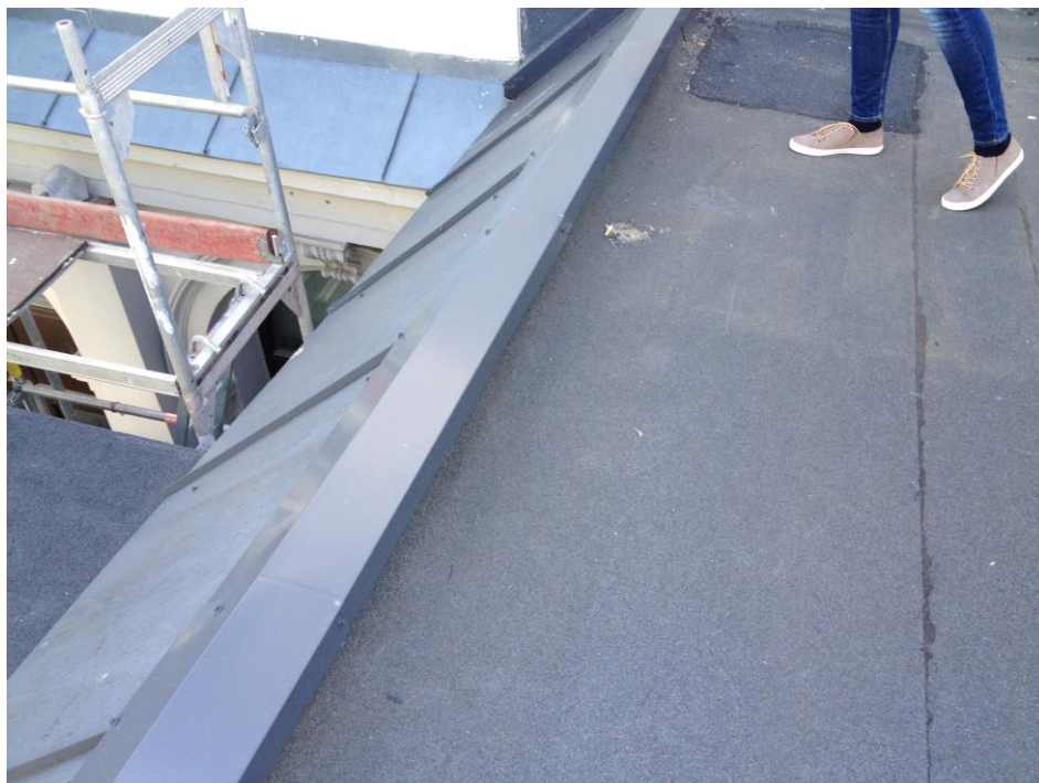
Figur 19: Foto av overgang mot lavereliggende tak i retning øst. (Rambøll)
