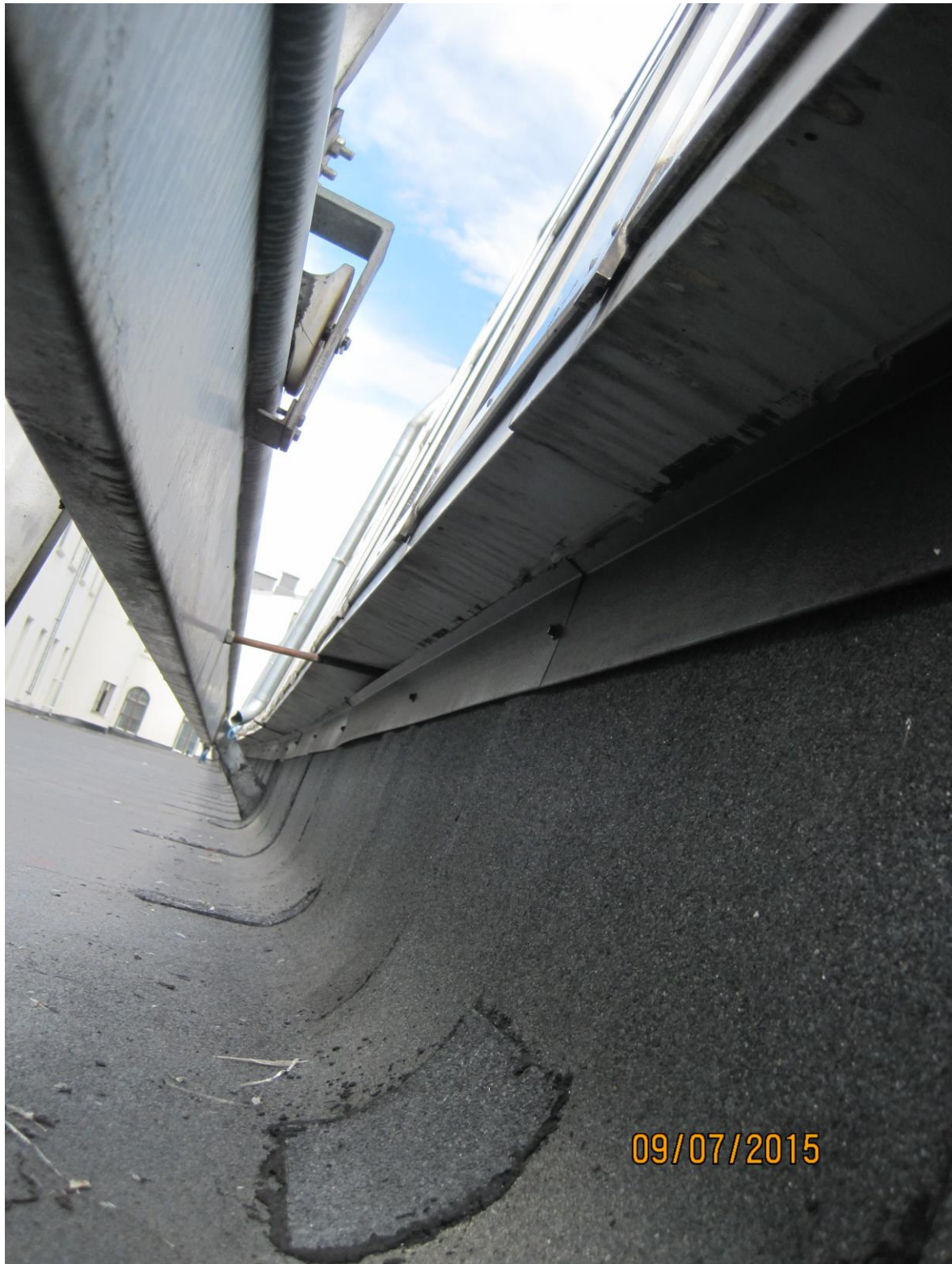
Figur 21: Foto av overgang taktekkning / opprinnelig glasshall. (Rambøll)
