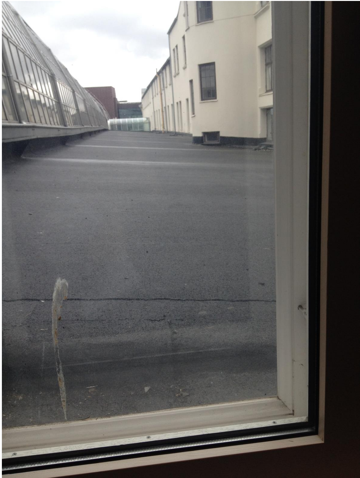
Figur 11: Foto av flatt tak på sørsiden av glasshall, tatt i retning øst gjennom vindu i vestfasade. (Rambøll)
