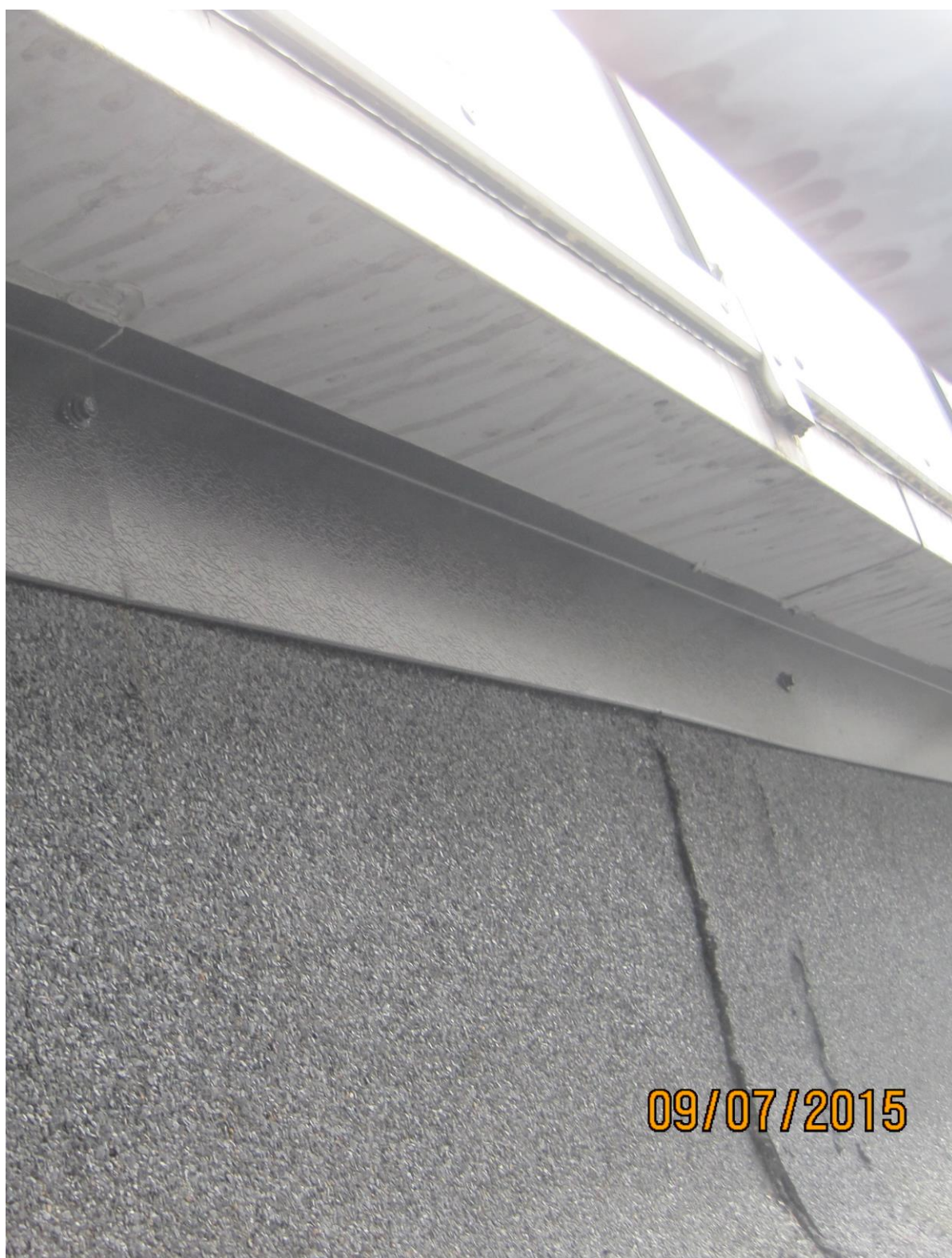
Figur 22: Nærbilde av overgang takteking/opprinnelig glasshall. (Rambøll)
