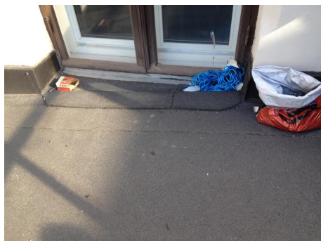
Figur 3: Foto av overgang mellom vindu i pusset yttervegg mot vest og taktekking på kompakttak sør for opprinnelig glasshall (Rambøll).
