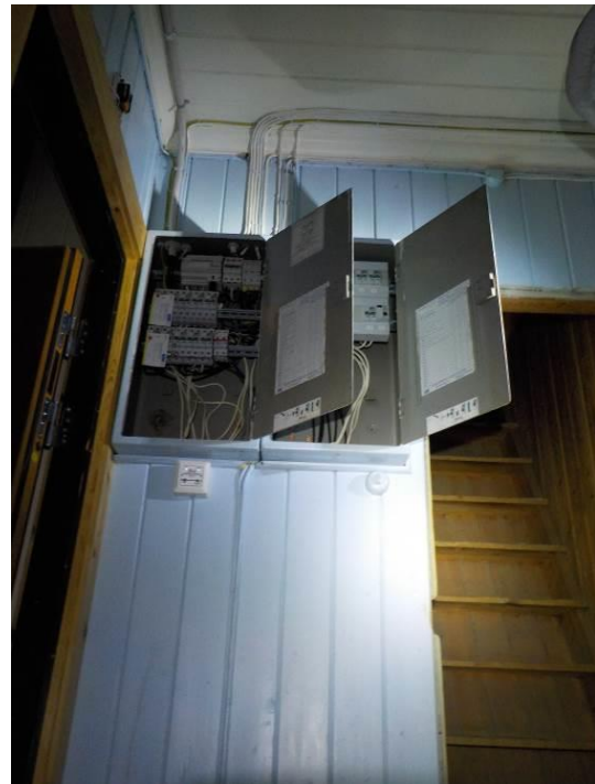
Bilde 13 viser eksempel på fastmontert EE-avfall; sikringsskap i kjeller.
