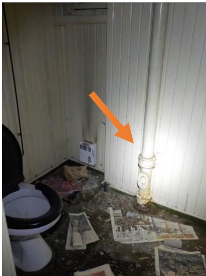
Bilde 8 viser soilrør på i rom kj7 (toalett) i kjeller
