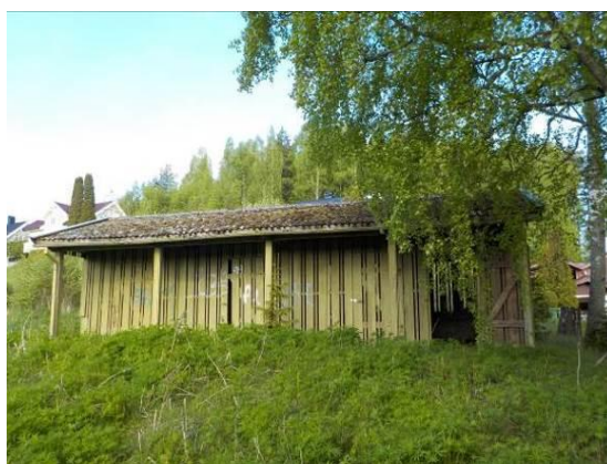
Bilde 2 viser skur i Sagaveien 32.
