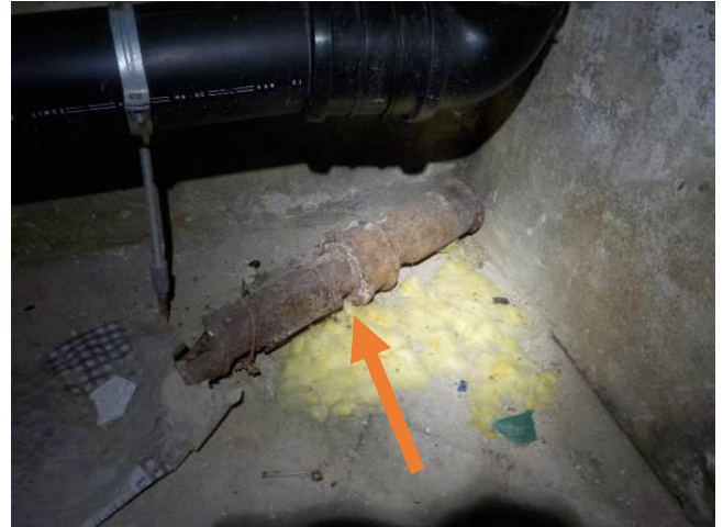
Bilde 7 viser soilrør i rom kj1 i kjeller.
