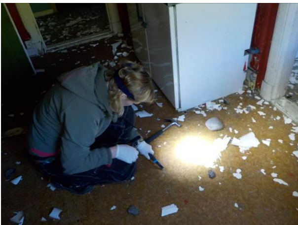
Bilde 16 viser sjekk av vinylbelegg på kjøkken i 2. etasje vest.
