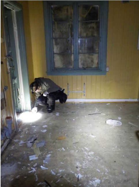
Bilde 14 viser sjekk av vinylbelegg på gulv på kjøkken i 1. etasje vest
