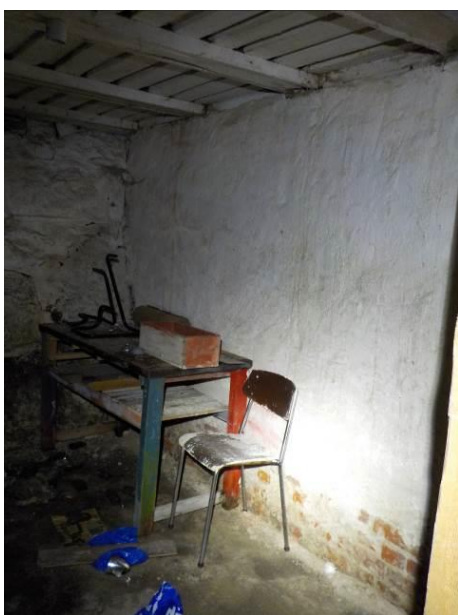
Bilde 19 viser hvitmaling på pusset tegl i kjeller. Malingen er forurenset med bly.
