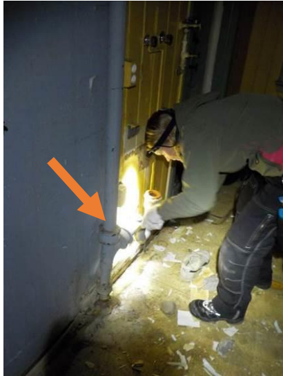
Bilde 6 viser soilrør på kjøkken i 1. etasje vest.
