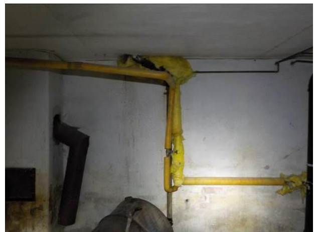
Bilde 11 viser cellegummi i rom kj1 i kjeller.
