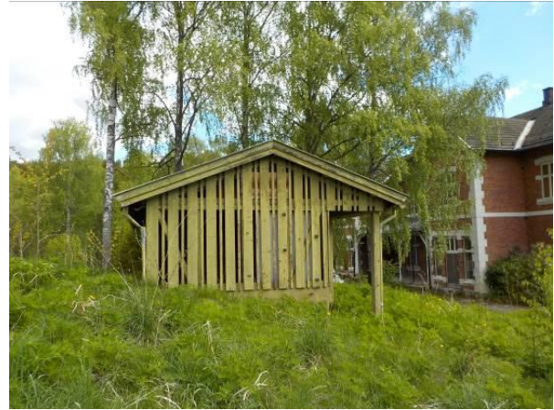
Bilde 22 viser grønn maling på trevirke på skur. Malingen er ikke farlig avfall.
