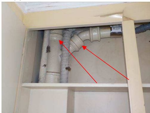
Bilde 3 Viser soilrør med skjøter, delvis skjult bak skap i rom 15
