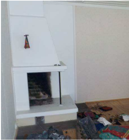
Bilde 13 viser pipe i stue i bolighuset
