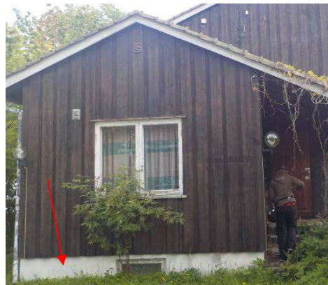
Bilde 9 Viser hvitmalt betong i grunnmur utendørs, for bolighus
