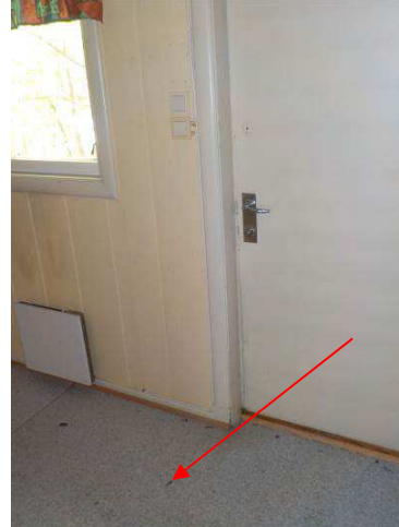
Bilde 7 Viser grått vinylbelegg på gulv i rom 13
