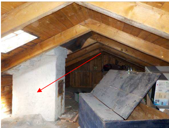
Bilde 11 Viser hvitmalt pusset tegl i pipe på loft
