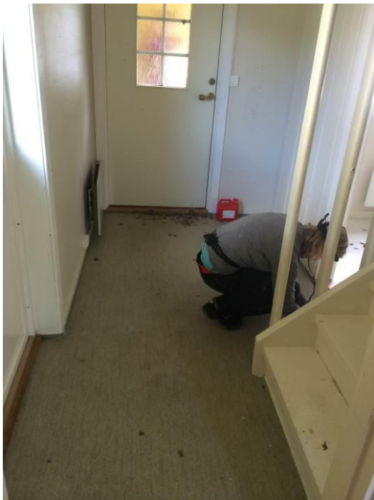
Bilde 6 viser vinylbelegg på gulv i gang i 1. etasje i 9B.
