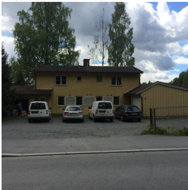
Bilde 24 viser lokasjon av pipe i bygget.
