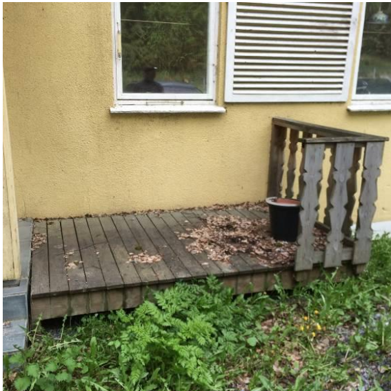
Bilde 3 viser platting med CCA-impregnert trevirke på fremsiden av 9A, ved parkeringsplass.
