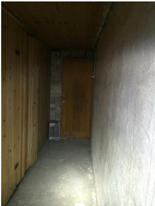
Bilde 19 viser hvitmalt betongvegg i kjeller. Malingen er ikke forurenset med PCB eller tungmetaller.
