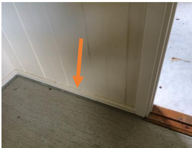
Bilde 10 viser vinylister i gang i 1. etasje i 9B.
