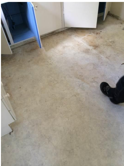
Bilde 8 viser vinylbelegg på gulv på kjøkken i 1. etasje i 9B.
