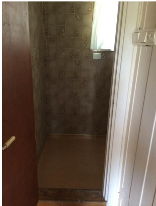
Bilde 7 viser vinylbelegg på gulv og vinyltapet på vegger på bad i 2. etasje i 9B.
