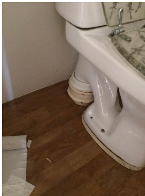
Bilde 9 viser vinylbelegg på gulv på toalett i 2. etasje i 9B.
