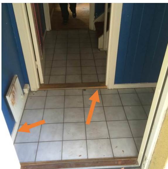
Bilde 15 viser fugemasse i gang og trapperom i 1. etasje i 9A.
