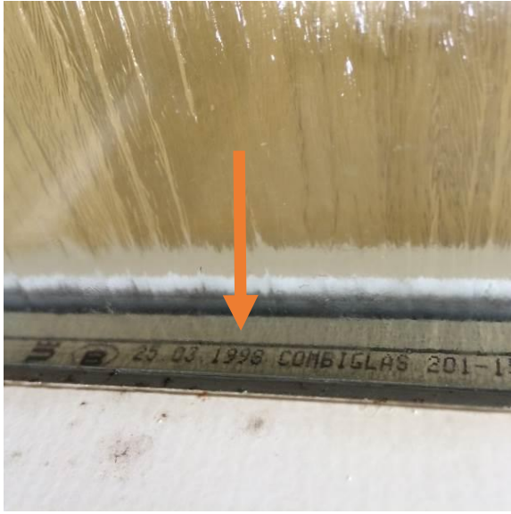
Bilde 12 viser eksempel på merking av årstall i avstandslist i isolerglassrute.
