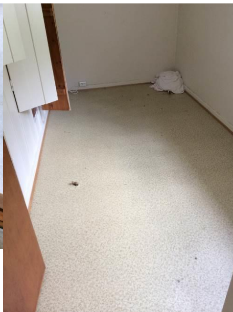
Bilde 11 viser vinylbeleg på gulv på rom 9B1 i 2. etasje i 9B.
