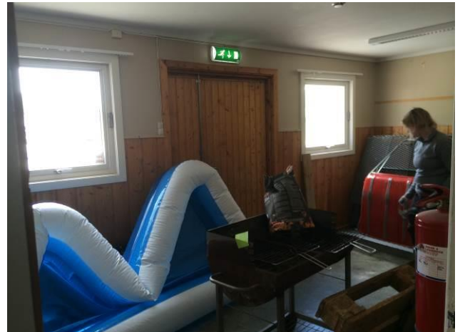
Bilde 9 viser de to isolerglassrutene fra 1976 i rom 2 i 1. etasje.
