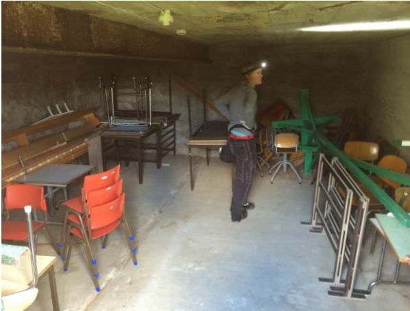
Bilde 13 viser kjeller med umalt betong, der betongprøve ble tatt.
