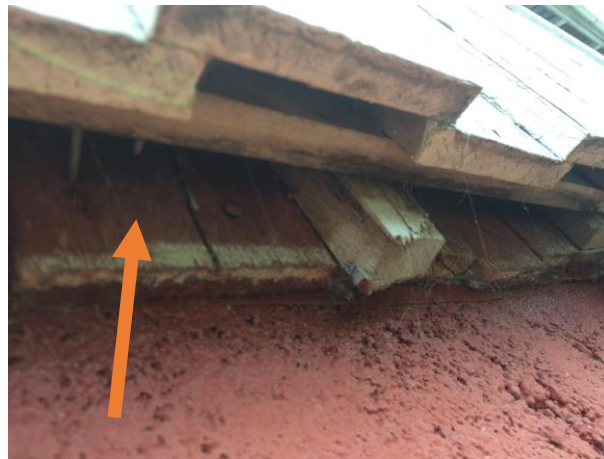
Bilde 12 viser rødmalt kledning under hvitmalt kledning.
