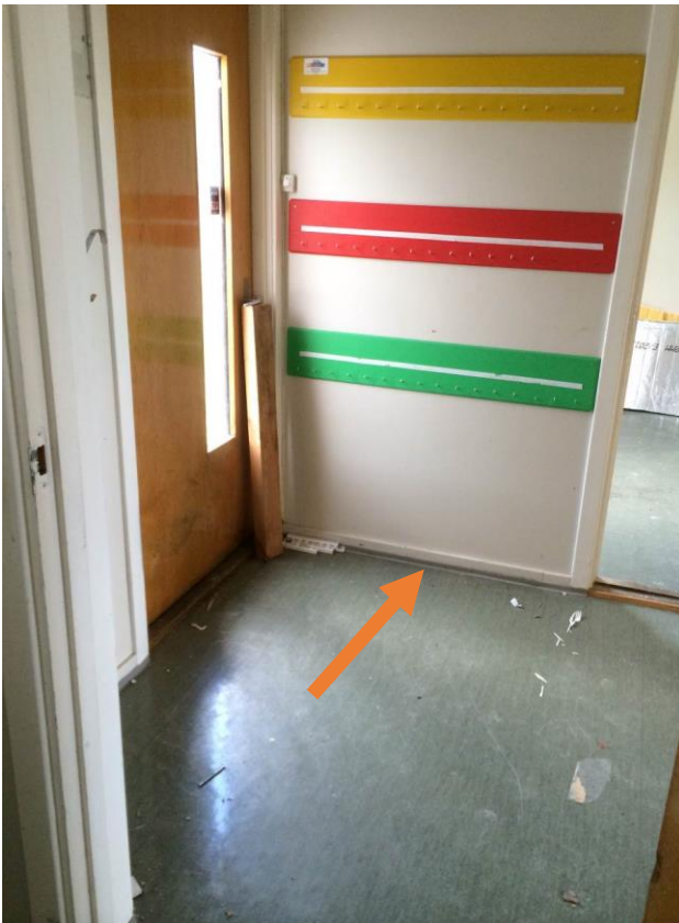
Bilde 7 viser eksempel på vinyllist i 1. etasje.
