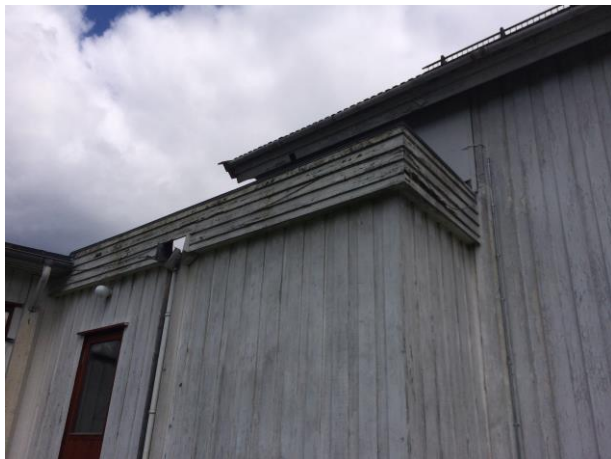
Bilde 11 viser hvitmaling på fasade.
