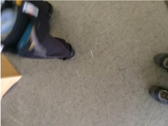
Bilde 5 viser eksempel på vinylbelegg på gulv i 1. etasje.
