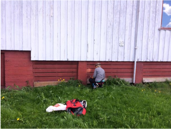
Bilde 10 viser prøvetaking av maling på fasade.
