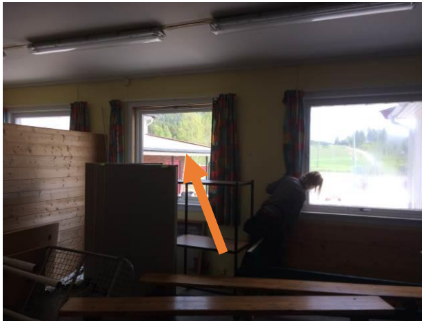
Bilde 8 viser plassering av isolerglassrute fra 2003 i rom 1 i 1. etasje (vinduet i midten av de tre).
