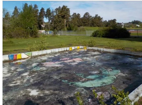
Bilde 8 Viser basseng 3. Maling på bassenget er forurenset. Betong i bassenget er ren.
