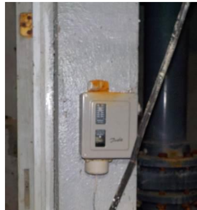
Bilde 5 Viser el. termometer som eksempel på EE-avfall. Termometeret inneholder kvikksølv. Det er viktig at termometeret ikke knuses.
