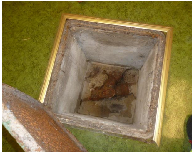
Bilde 10: Blyskjøter finnes på blant annet bunnledninger i bygget. Bildet viser inspeksjonsluke for bunnledninger i kjelleren. I tillegg finnes slike blyskjøter innebygget i vegger i forbindelse med avløp i bygget.
