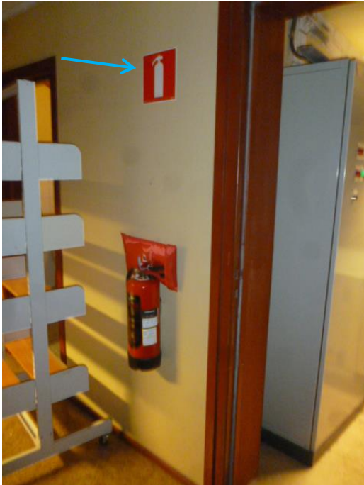
Bilde 9: I tiltaksområdene finnes det ABC-pulverapparater som er farlig avfall med ammoniumsulfat. I bildet vises det også radioaktivt ledeskilt over pulverapparatet (blå pil).
