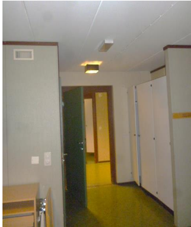
Bilde 18: Gråaktig veggtapet som er farlig avfall med ftalater i beboerfløyen fra 1979.
