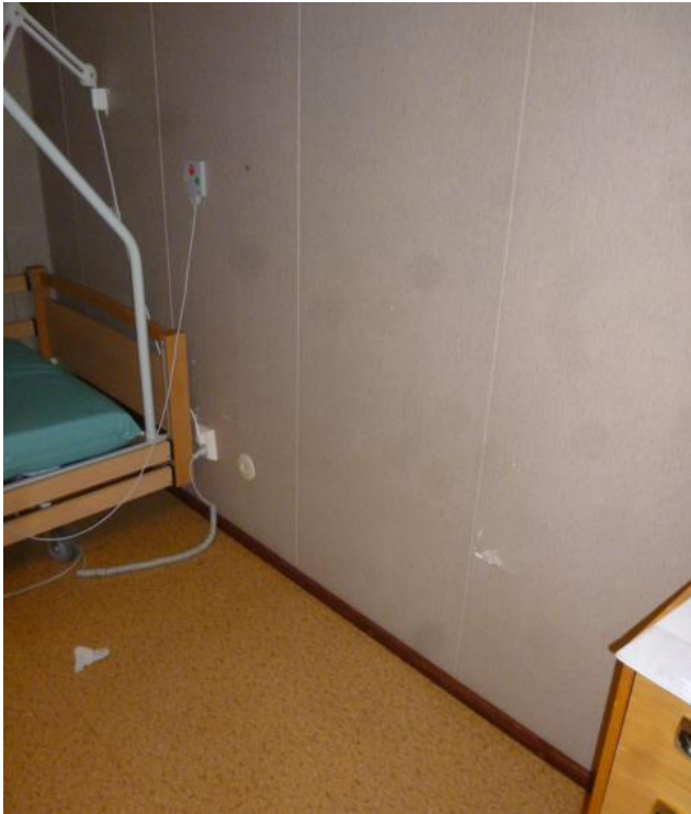
Bilde 17: Veggtapeter ved den østlige fløyen fra 1979 er farlig avfall med ftalater. Veggtapeten er benyttet på beboerrom i den østlige fløyen.
