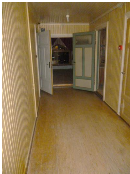
Bilde 22: Innvendige veggmalinger på trepanel i den eldste delen av vestfløyen er farlig avfall med sink på grunn av de eldre malingene som er benyttet her. Linoleum gulvbelegg her er farlig avfall med bly.
