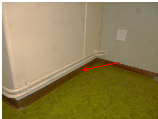
Bilde 16: Myke vinyl gulvlister er benyttet i ganske stort omfang i alle deler av bygget.
