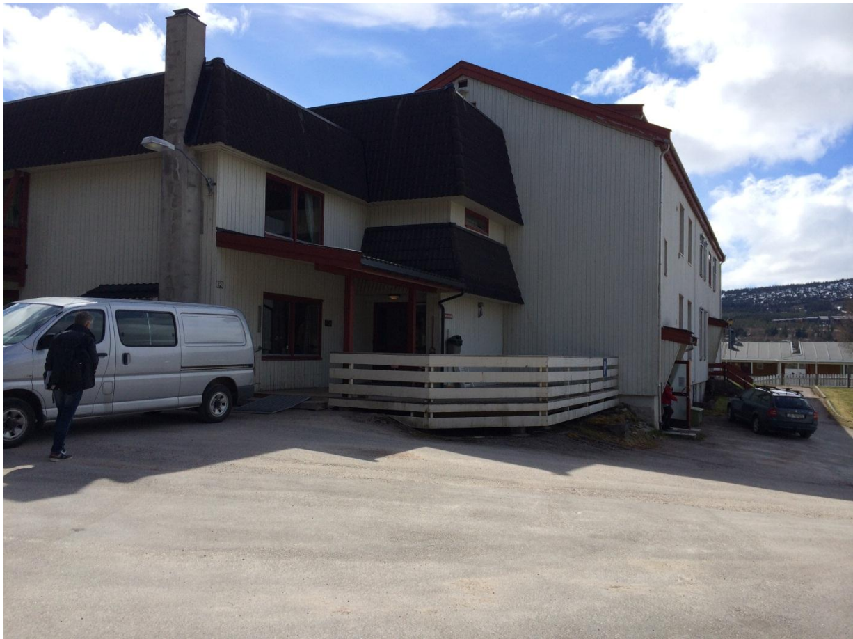
Bilde 1: Trysil aldershjem, sett mot eksisterende inngangsparti.
