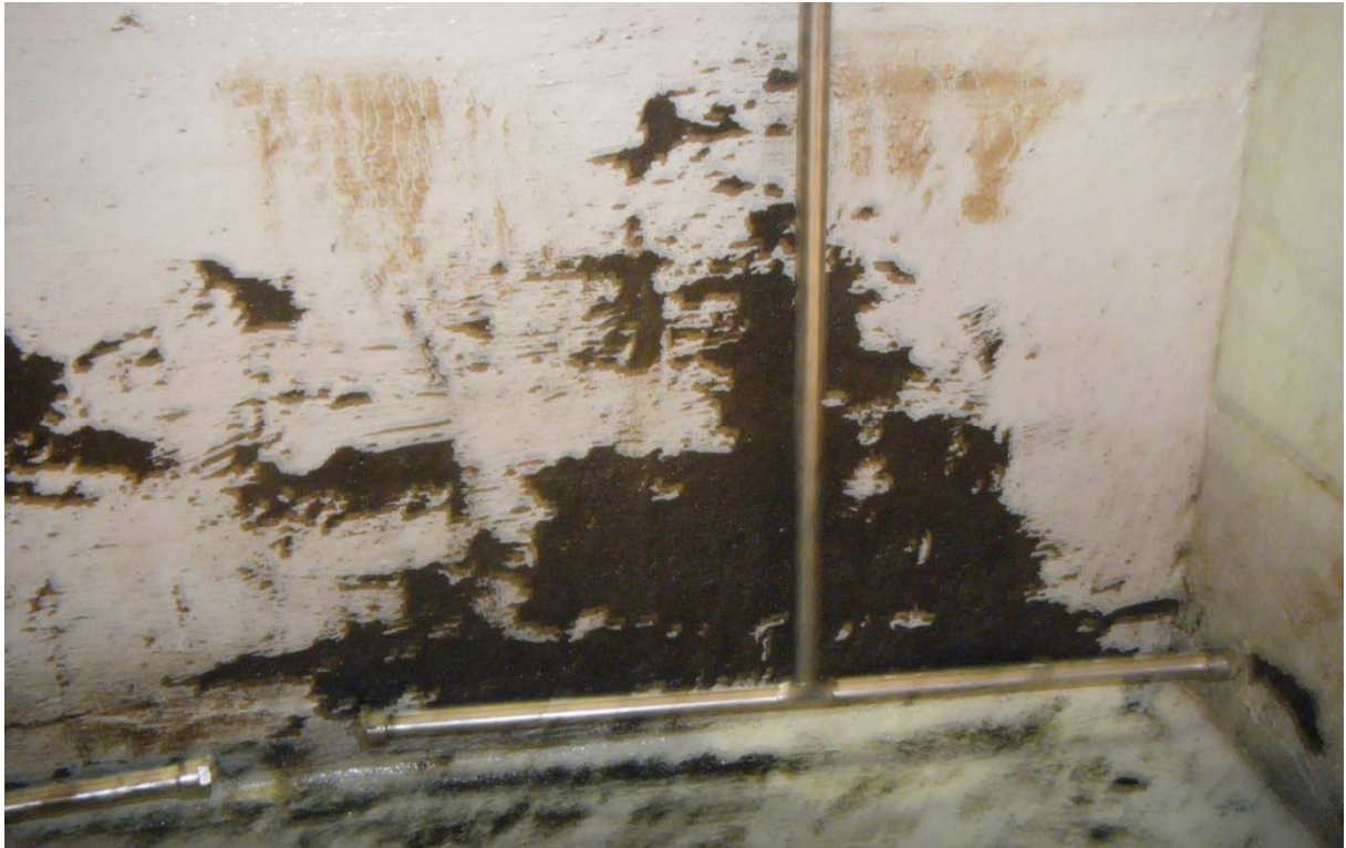
Overgang golv vegg.
