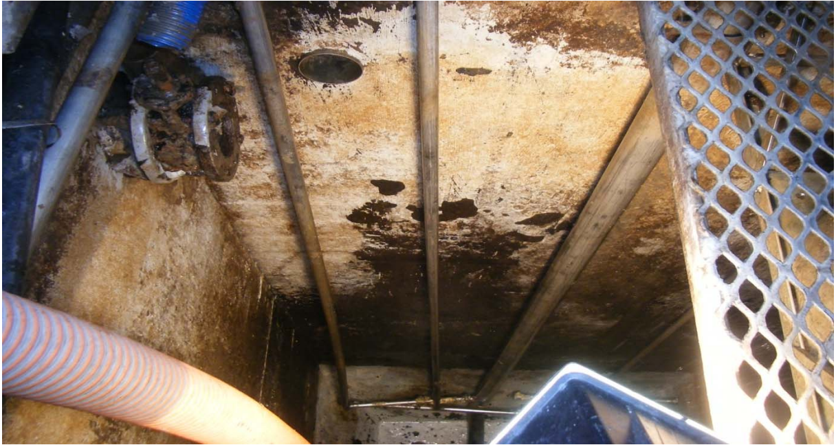
Vegg mot luftbasseng
