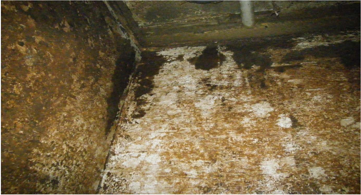
Vegg oppunder dekke
