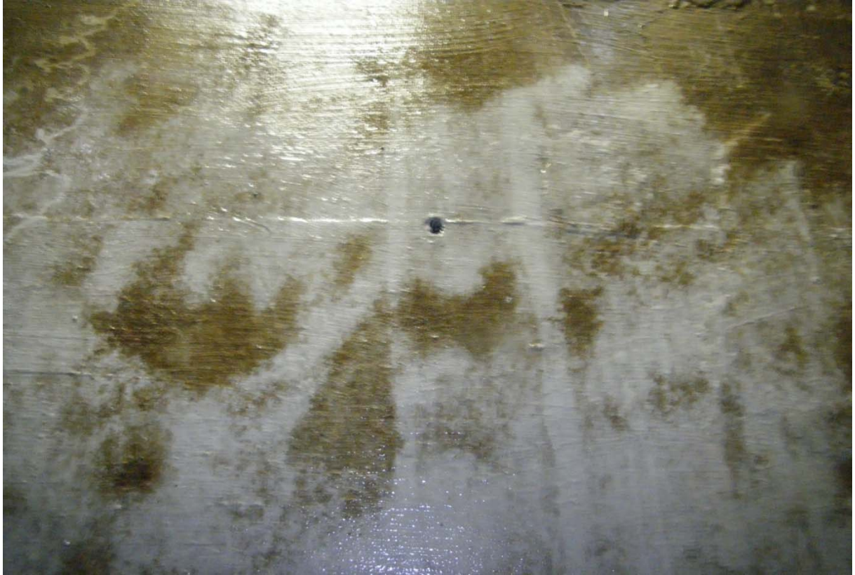
Hull etter forskalingsstag
