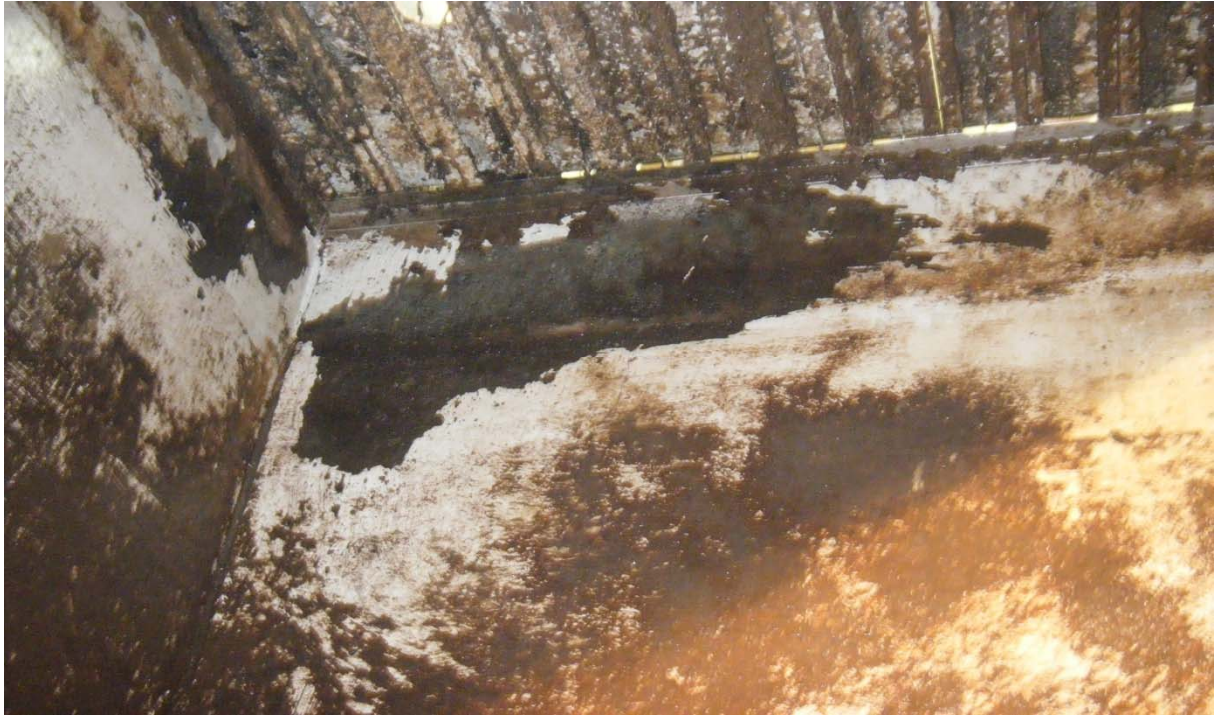
Vegg i luftebasseng
