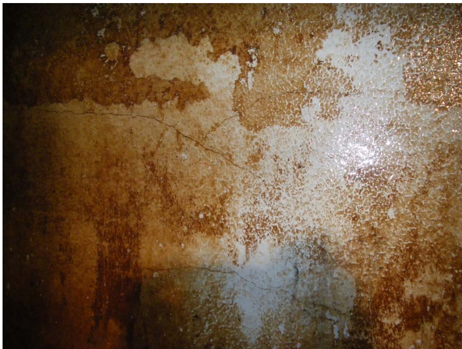
Vegg med sprekker i epoxy
