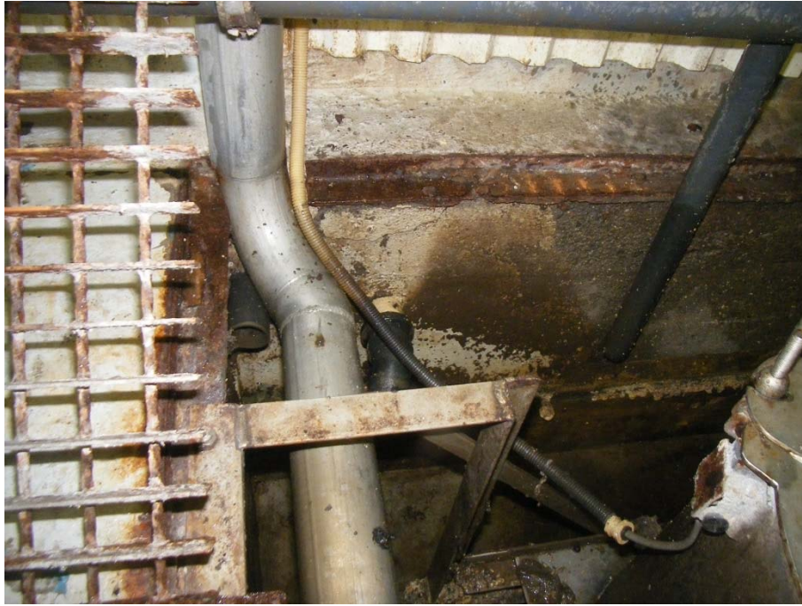
Rett på betongen rundt kverna.
