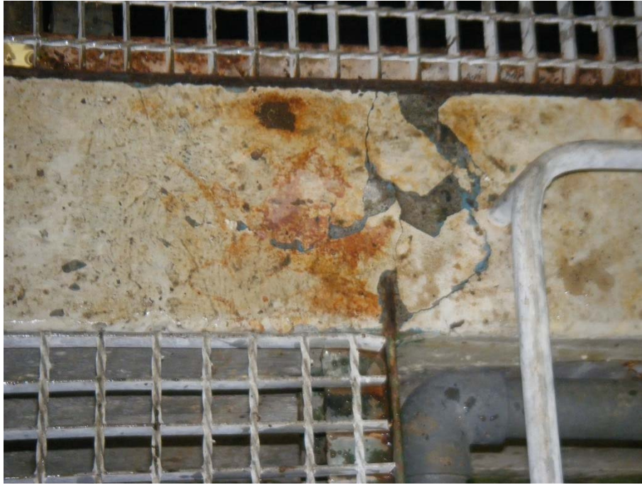
Innstøpt ståldrager, rustsprengning rundt punktet.
