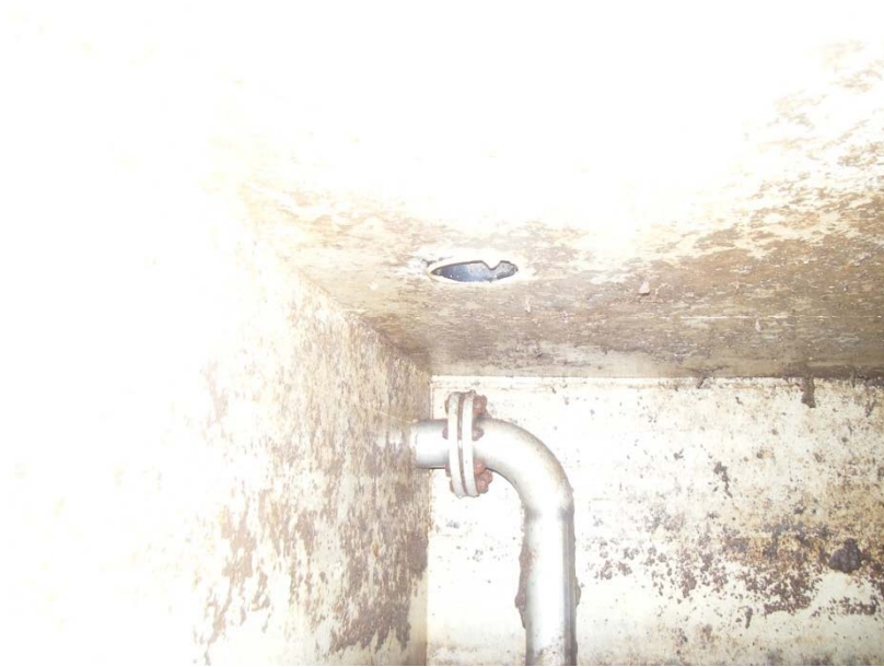
Dekke og øvre del av vegg med sugerør for slam virker ok.
