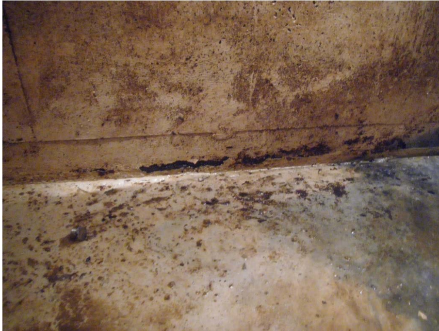
Overgang golv vegg.
