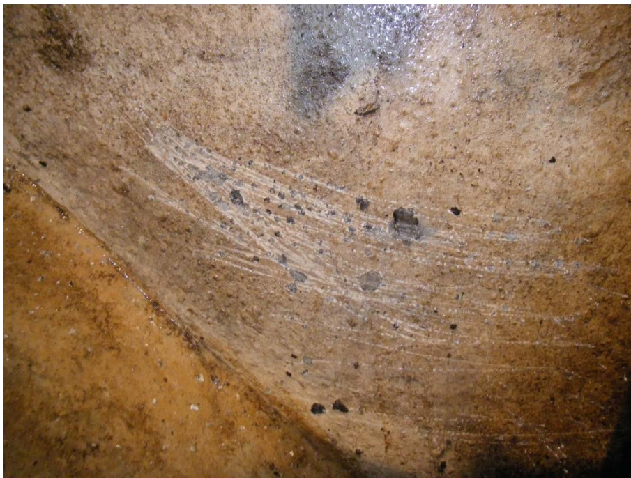
Vegg med blemmer i epoxy og sår i betong.
