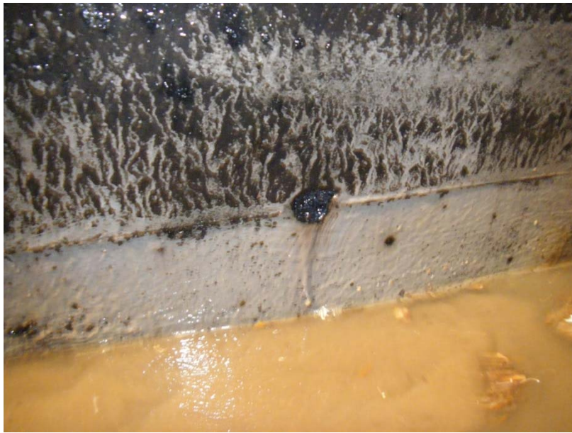
Rust på forskalingsstag på fleire punkter.
