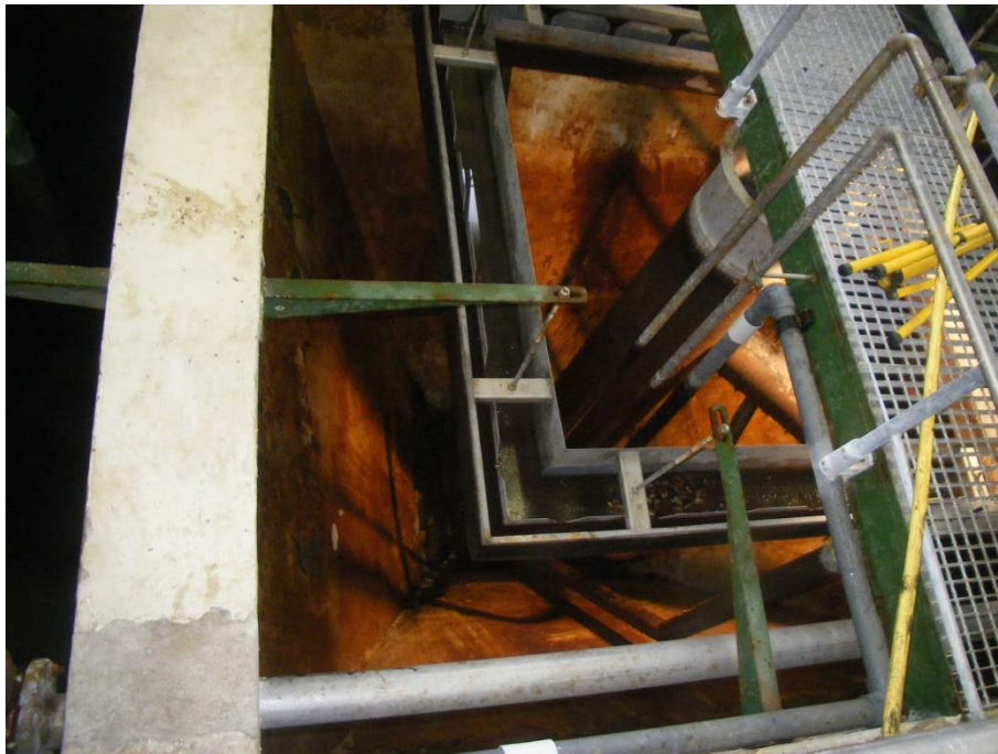
Innstøpt ståldrager, rustsprengning rundt punktet.
