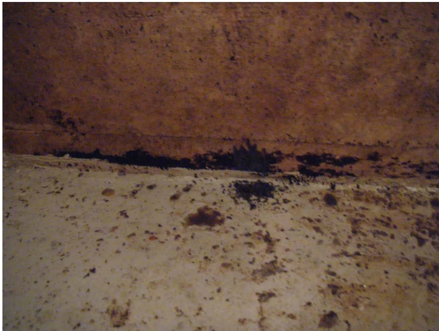
Overgang golv vegg, epoxy borte.
