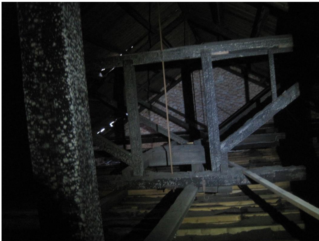
Fotos tatt av takverk. Legg merke til gamle sot- og brannskader samt soppskader.
