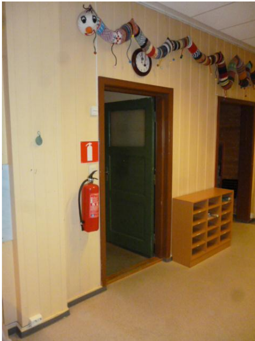
Bilde 1: I tiltaksområdene finnes det ABC-pulverapparater som er farlig avfall med ammoniumsulfat. I bildet vises det også radioaktivt ledeskilt over pulverapparatet. Døren i bildet har blytråder i glasset, men er ikke farlig avfall.
