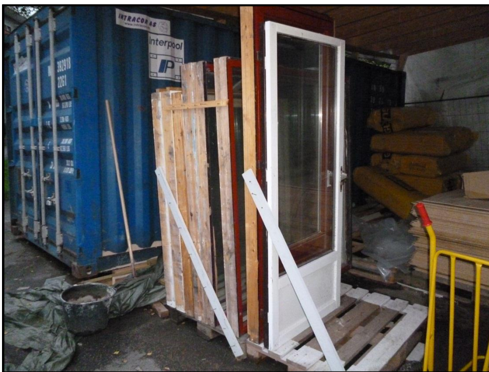
Figur 5 Slik kan vinduer og balkongdører klargjøres for transport.
