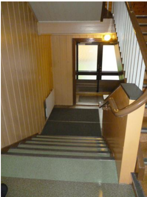
Bilde 7: Ved trapp ved inngangspartiet skal det åpnes opp i vegg til venstre ved inngangspartiet for å etablere inngangen for heis. Ved inngangspartiet er det benyttet terrasso betongdekke, og det samme gjelder for betongtrapp ned mot kjeller. I selve trappen ligger det vinyl gulvbelegg.
