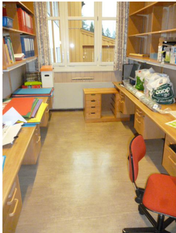
Bilde 8: Innvendige gulv i de aller fleste klasserom er vinyl gulvbelegg som er farlig avfall med ftalater. Isolerglassvinduene i dette rommet er fra 2008 og inneholder isocyanater. Vinduene håndteres som farlig avfall hvis de skal rives.
